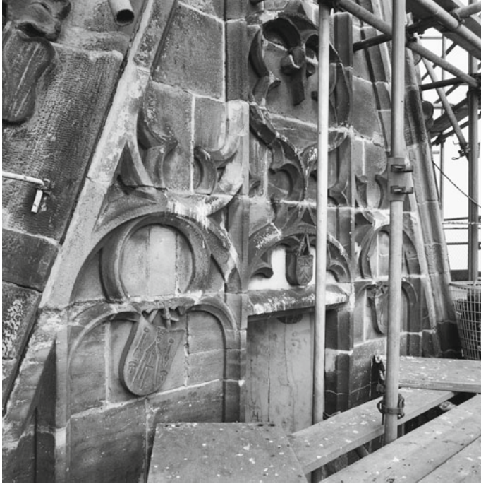
Fig. 10 Delft, New Church: escutcheons of the masons and the master builder on the southeast gable (Rijksdienst voor het Cultureel Erfgoed, Amersfoort)
