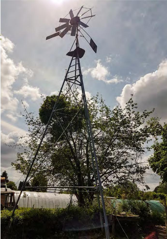
– weithin sichtbar – zwei Windräder. Sie sind aus Gebrauchtmaterialien zusammengesetzt, erklärt der gärtnernde Windradbauer Philipp Balcke, und versorgen Lampen, Radio, Rasenmäher, Wasserfasspumpe, Heckenschere, Apfelsaftpresse, Häcksel und Kettensäge, also alles, was man im Garten so braucht, mit dem nötigen Strom. Der Blüchergarten entstand als Grabegartengemeinschaft schon Mitte der 1980er Jahre und darf somit als Vorläufer der Urban-Gardening-Bewegung gelten. Kurz vor
