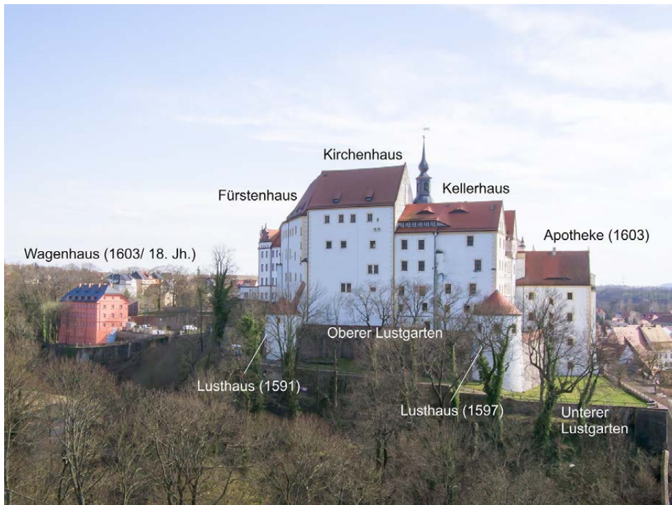
Abbildung 55. Colditz, Schloss Colditz, Hauptbauphasen: 11.–12. Jahrhundert, 15. Jahrhundert, 1519–1525, um 1600, Ansicht von Norden
