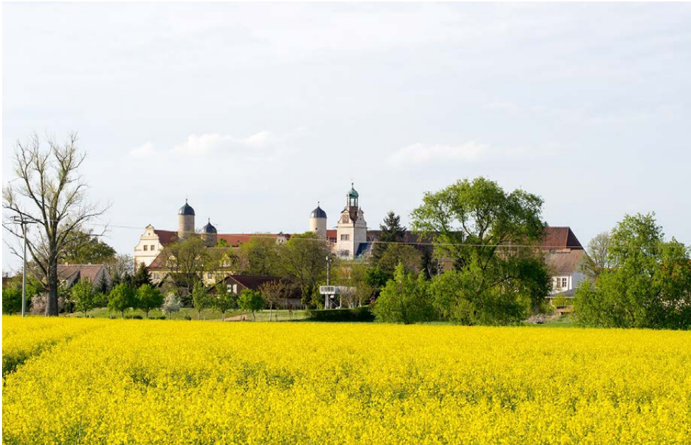
Abbildung 113. Prettin, Schloss Lichtenburg, Ausbau 1577–1582, Ansicht von Südwesten
