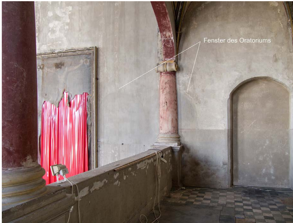
Abbildung 144. Prettin, Schloss Lichtenburg, Schlosskapelle, untere Empore von 1577–1582, ehem. Fenster des Oratoriums (1.35) von 1565–1577 (?), vermauert zwischen 1812 und 1851
