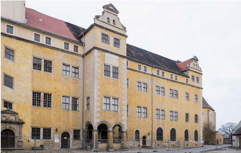
Abbildung 125. Prettin, Schloss Lichtenburg, Flügel D1, Hoffassade mit vergrößerten Rundbogenfenstern im Erdgeschoss, kurz nach 1611, Ansicht von Südwesten
