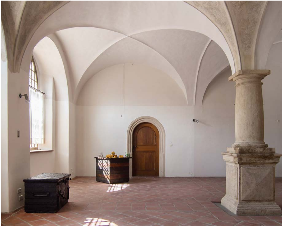
Abbildung 145. Prettin, Schloss Lichtenburg, Flügel D1, Erdgeschoss, Apotheke (0.34), vor 1611 Silberkammer, Ansicht von Osten
