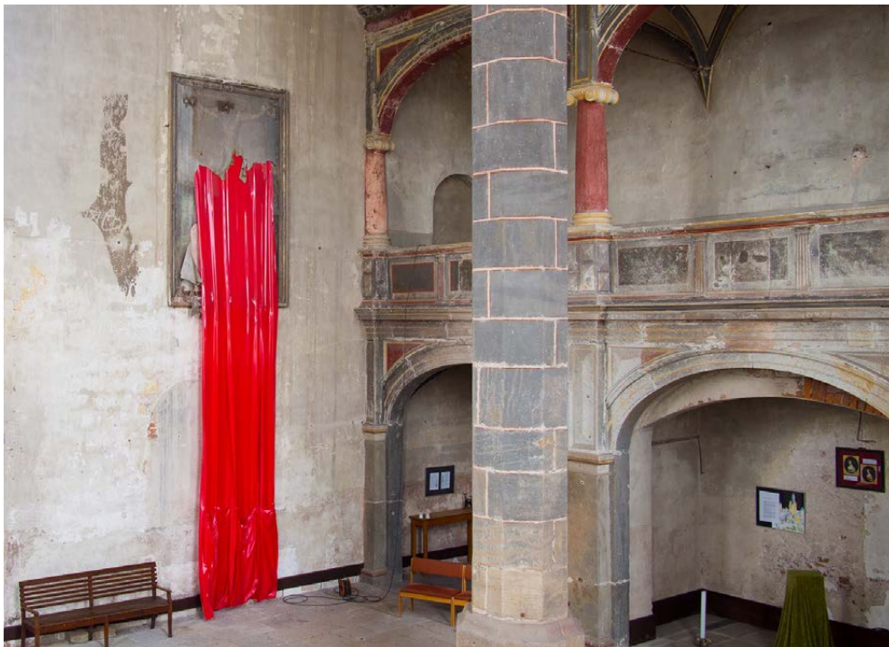
Abbildung 1. Prettin, Schloss Lichtenburg, Schlosskapelle, Kunstinstallation der Hochschule Burg Giebichenstein, 1997, Ansicht von Nordosten, Aufnahme von 2018
