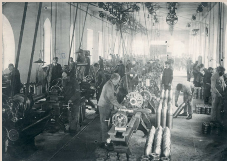
Abb. III/38 In der Geschossdreherei (heute Halle 3) der Jenbacher Berg- und Hüttenwerke wurden 15-cm-Gussgranaten für den Ersten Weltkrieg gedreht, 1915.
