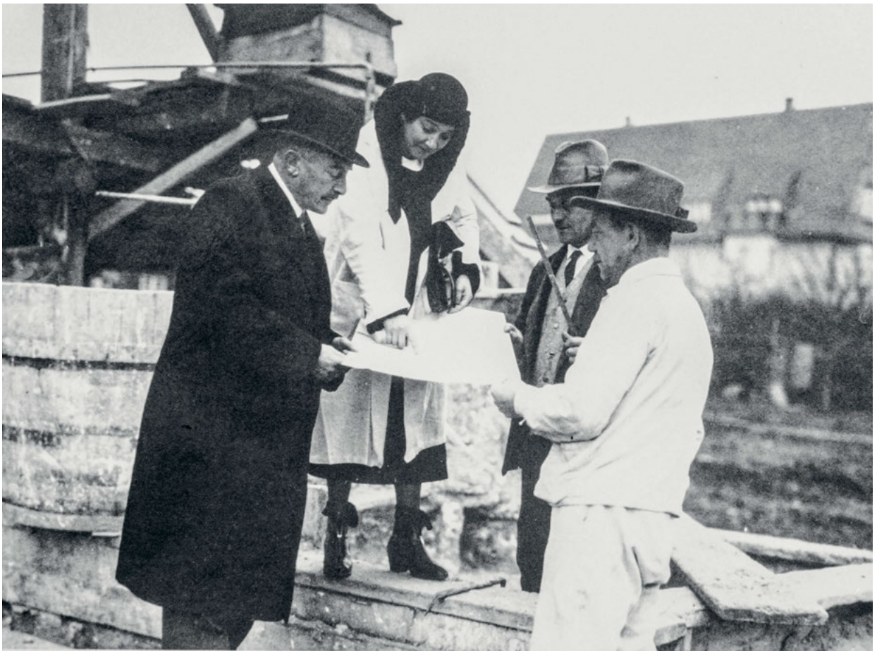
Abb. V/3 Liane Zimble auf der Baustelle, 1920er Jahre.
