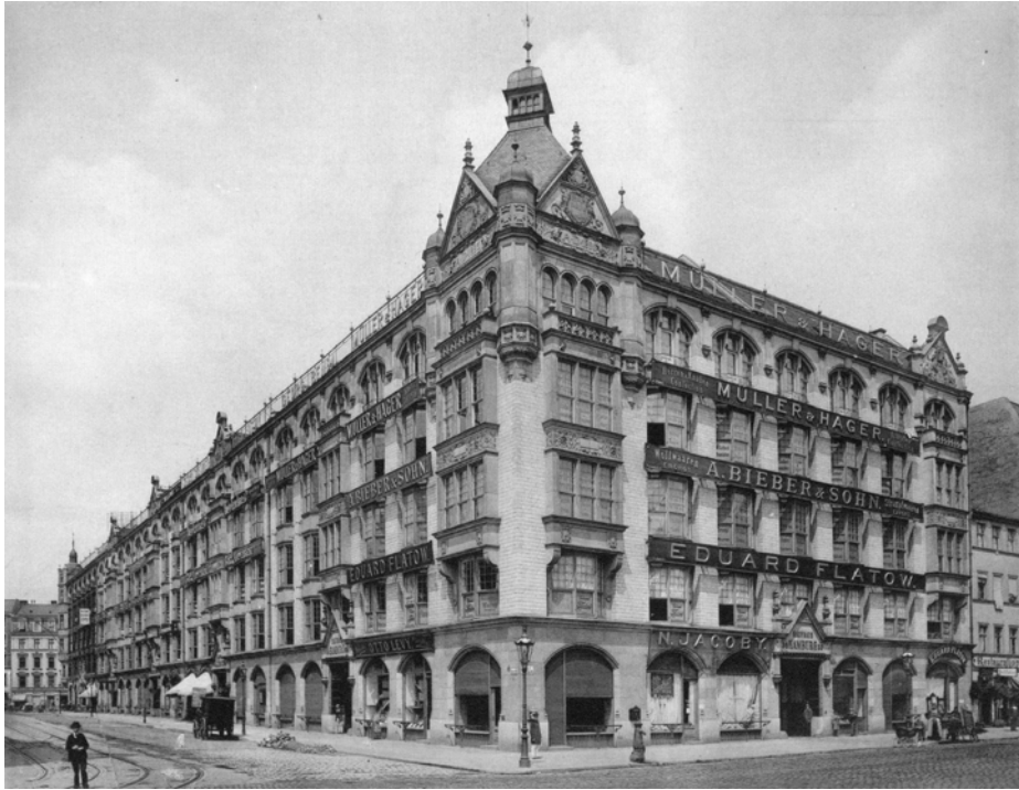
Abb. 10: Neubauten am Straßendurchbruch, Kaufhaus Kaiser-Wilhelm-Straße 33–36, 1894–1895, Architekten Heinrich Joseph Kayser und Karl von Großheim. © Blätter für Architektur und Kunsthandwerk 11 (1898), Tafel 109; gemeinfrei unter: https://digital.zlb.de/viewer/image/16054086_1898/318/ [abgerufen am: 24. Juli 2023].
