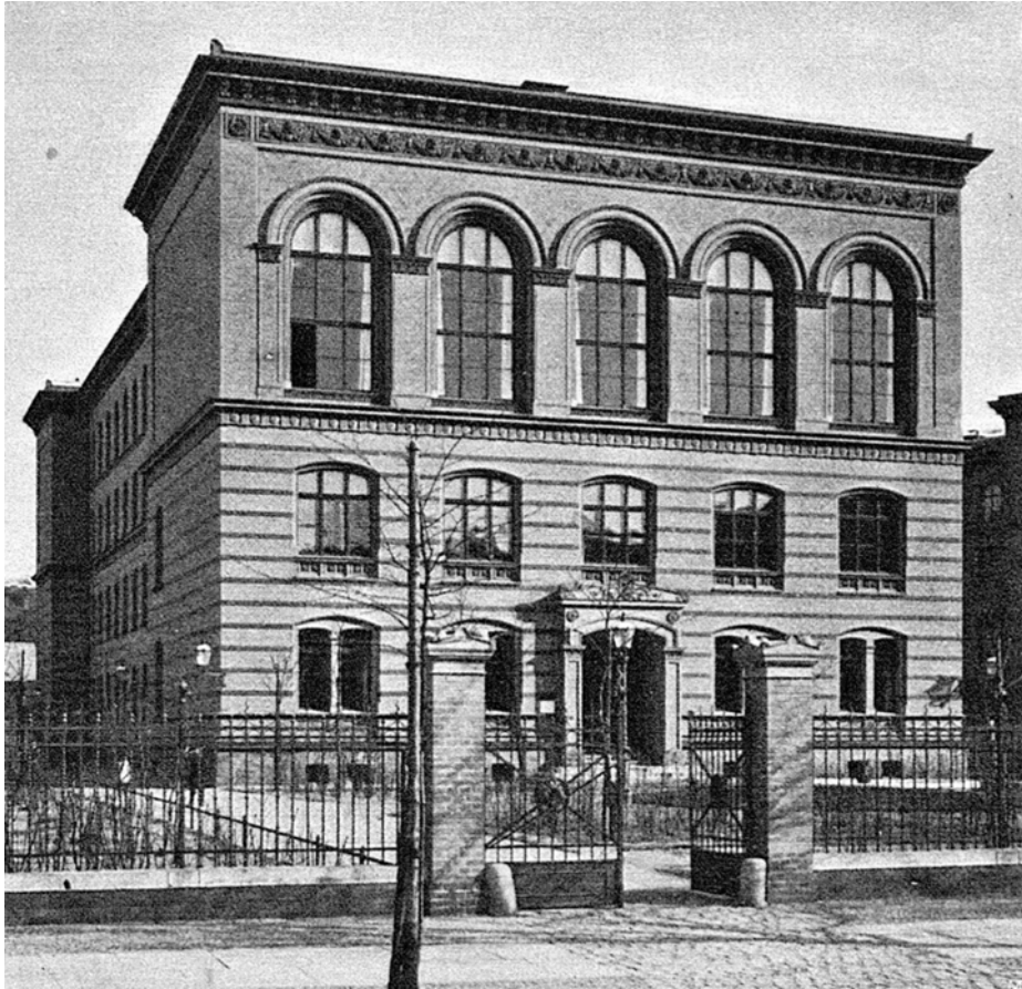
Abb. 7: Lessing-Gymnasium Pankstraße 1884–1887, Architekt: Hermann Blankenstein. © Architektenverein zu Berlin/Vereinigung Berliner Architekten (Hrsg.), Berlin und seine Bauten, Bd. II und III: Hochbauten, Berlin 1896, S. 311, Abb. 315; gemeinfrei unter: https://digital.zlb.de/viewer/image/16337878/363/ [abgerufen am: 24. Juli 2023].
