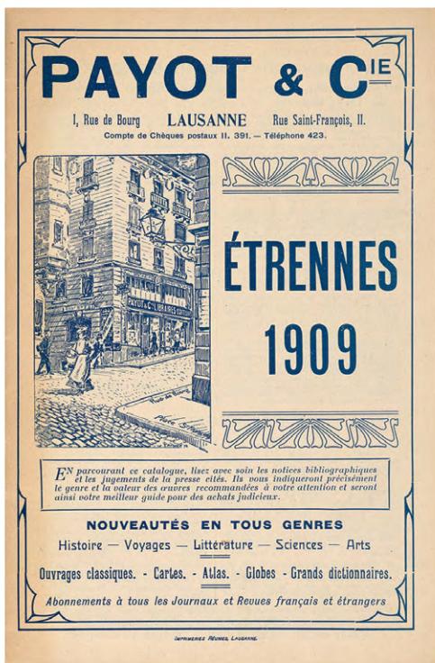
1 Immeuble Payot avant sa reconstruction sur le catalogue d'Étrennes 1909. Source: Musée historique de Lausanne, fonds Bridel, 213.
