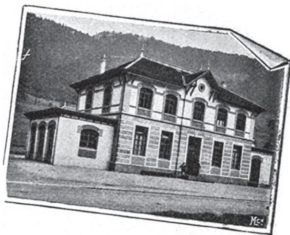
Fig. 8-23: Saint-Sulpice (NE), salle de gymnastique construite en 1899.
