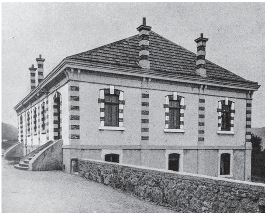
Fig. 8-20: Cernier, Val-de-Ruz (NE), halle de gymnastique construite en 1896.
