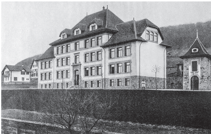
Fig. 8-28: Peseux (NE), collège des Guches, construit en 1914.
