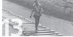
Ouagadougou, Burkina Faso La bataille du rail: 150 volontaires viennent chaque jour travailler sur le chantier. J.-C. Gadmer | CIRIC
