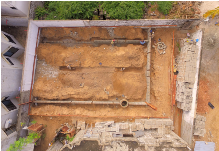
SURVEILLANCE DE CHANTIER PAR DRONE, COTONOU, 2019 [© ACML].
