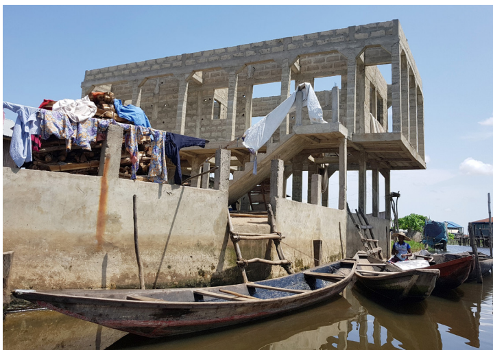
MAISON EN CONSTRUCTION, GANVIÉ, 2017 (@ACML).
