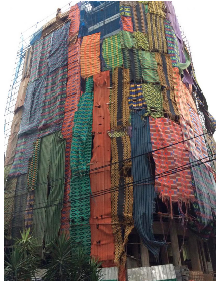
IMMEUBLE EN CONSTRUCTION RECOUVERT DE PAGNES, DAKAR, 2019 (© E. BARRAL).
