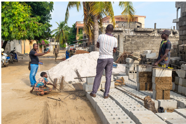
RÉUNION DE CHANTIER, COTONOU, 2018 (©ACML).
