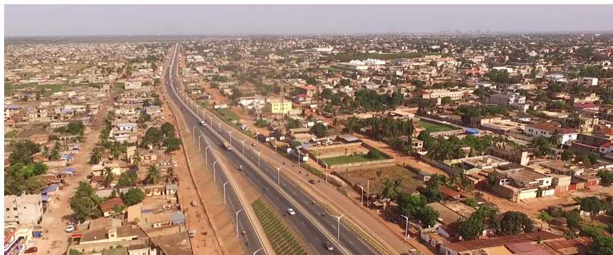
LE CORRIDOR AU NIVEAU DE COTONOU (@ACML).
