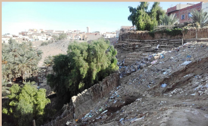
SURPLOMB DE L'EXTRÉMITÉ DE LA CORBEILLE (© DAVID GOEURY).
