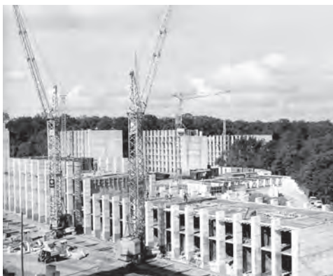
VUE D'UNE CUISINE-TÉMOIN RÉALISÉE POUR LE POINT DU JOUR EN 1958 [À GAUCHE] ET PROGRESSION DU CHANTIER DE LA RÉSIDENCE DU PARC À MEUDON-LA-FORÊT EN 1957 [À DROITE]. FERNAND POUILLON ARCHITECTE. SOURCE: LUCAN (2003: 114, 145).
