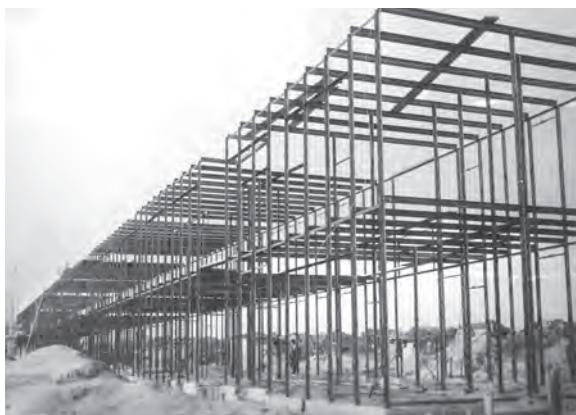
LE CHANTIER DE LA SIEDLUNG BLUMLÄGER FELD À CELLE EN 1930, OTTO HAESLER ARCHITECTE [À GAUCHE]. UNE HABITATION VERNACULAIRE CONSTRUITE EN PIERRES, À CORIPPO, EN SUISSE [À DROITE]. SOURCES: ARCHIVES DE LA VILLE DE CELLE (STADTACE), F 02, NR. 1436; ROSSI, CONSOLASCIO ET BOSSHARD (1979: 681).
