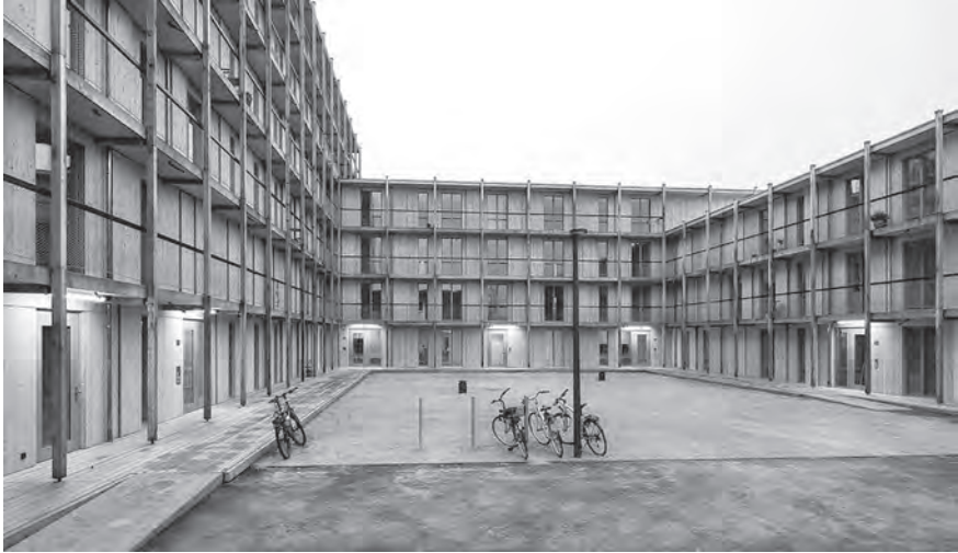
L'ENSEMBLE HAGMANNAREAL RÉALISÉ EN 2017 PAR SOPPELSA ARCHITEKTEN À WINTERTHUR (SUISSE) DONNE UNE EMPHASE PARTICULIÈRE À L'ESPACE COLLECTIF PLACÉ AU CENTRE DU DISPOSITIF SOURCE: PHOTOGRAPHIE VOLKER SCHÖPP (2017), SOPPELSA ARCHITEKTEN.
