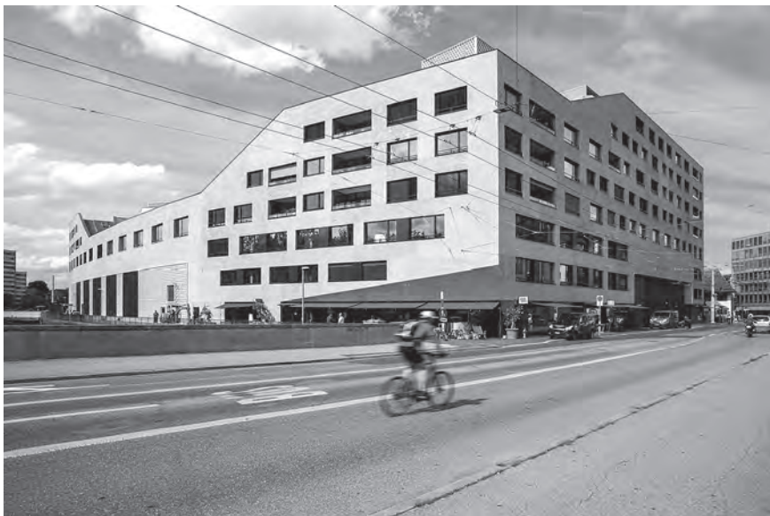
VUE DE LA COOPÉRATIVE KALKBREITE DEPUIS LA KALKBREITESTRASSE, À ZÜRICH (2014). SOURCE: COOPÉRATIVE KALKBREITE, VOLKER SCHOPP.
