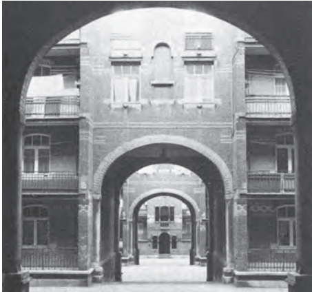
FINALISÉE EN 1915 SOUS LA DIRECTION D'ÉMILE HELLEMANS, LA CITÉ QUI PORTE SON NOM CORRESPOND AU PREMIER ENSEMBLE DE LOGEMENT SOCIAL RÉALISÉ À BRUXELLES DANS UNE VISÉE DE RÉDUCTION DE L'INSALUBRITÉ. SES QUALITÉS ARCHITECTURALES RECONNUES NE S'ACCORDENT PAS FORCÉMENT À LA RÉCEPTION SOCIALE ET DANS LE TEMPS DES COMMUNAUTÉS D'HABITANTS. SOURCE: SCHOONBRODT (1979: 182).
