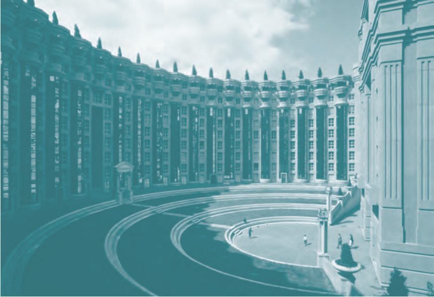
L'ensemble d'Abraxas réalisé par Ricardo Bofill en 1983 à Noisy-le-Grand convoque les références classiques de la vie politique, détachées de son usage effectif: en qualité de vide. Source: Ricardo Bofill, Taller de Arquitectura.
