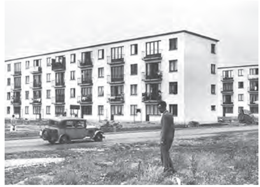
RÉALISÉE ENTRE 1929 ET 1931, LA SIEDLUNG WESTHAUSEN EST L'UNE DES EXPÉRIENCES MANIFESTES DE ERNST MAY À FRANCFORT (FERDINAND KRAMER AU PREMIER PLAN). SOURCE: PHOTOGRAPHIE PAUL WOLFF, ARCHIVES FERDINAND KRAMER, FRANCFORT.
