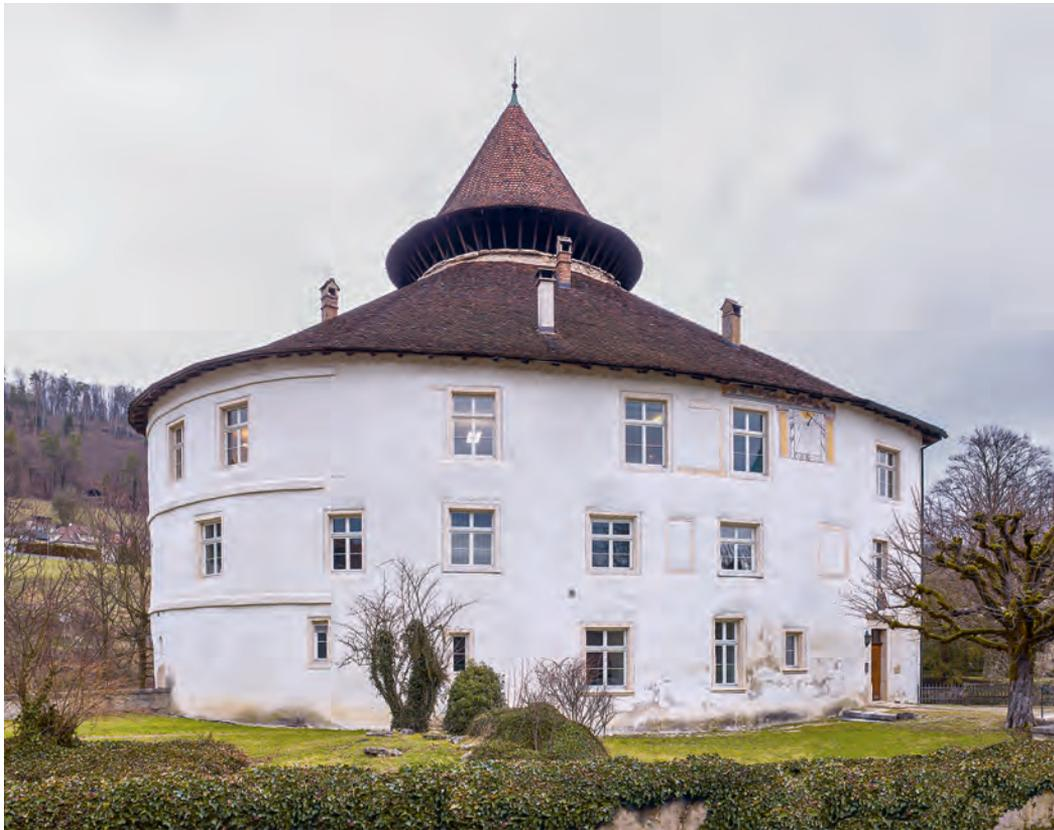
**ABB. 471** Zwingen. Schlossgasse 2. Schloss. Ansicht von Südwesten. Die Fassade lässt auf einen Blick in der Verteilung der z. T. vermauerten Fenster unterschiedliche Bauphasen erkennen. Die ursprüngliche niederere Anlage mit hoch darüber aufragendem Turm wurde im 16. Jh. aufgestockt. Von diesem Akt zeugt die 1591 datierte Sonnenuhr. Die Kordongesimse gegen Westen markieren den Übergang vom mittelalterlichen Palas zum Weiter- und Ausbau im 16. Jh. Foto Ariel Huber, Lausanne, 2018.
