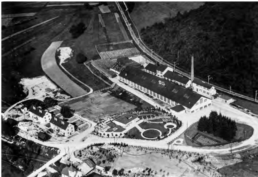
**ABB. 29** Papierfabrik Laufen. Flugaufnahme um 1930. Die jüngste der drei Papierfabriken steht auf dem Areal der früheren Dittinger Zementfabrik auf Zwingner Boden. Die Fabrikationsgebäude sind längsparallel zur Eisenbahn angeordnet. Im Vordergrund sind die beiden Reihenarbeiterwohnhäuser sowie das kleine, ursprünglich für die Zementfabrik errichtete Flusskraftwerk an der Birs erkennbar. (KD BL). Reproduktion Ariel Huber, Lausanne, 2021.
