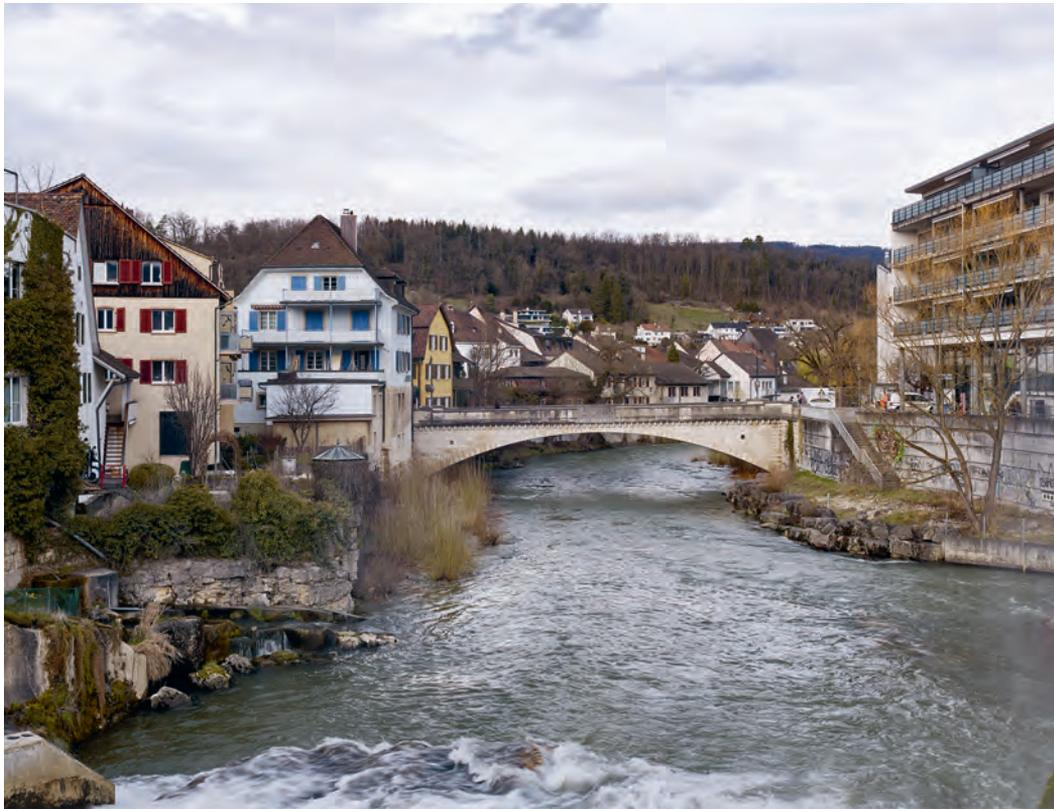
**ABB. 273** Laufen. Birsbrücke. Ansicht flussabwärts von Süden. Die Brücke besteht im Wesentlichen aus einer zwischen Widerlagern eingespannten stichbogenförmigen Eisenbetonkonstruktion von 30 m Spannweite. Die Betonkonstruktion wurde auf Wunsch des Gemeinderats der Stadt mit Laufner Kalkstein verkleidet. Links der Brücke ist das Gasthaus Krone (Vorstadtplatz 6) zu sehen. Foto Ariel Huber, Lausanne, 2020.
