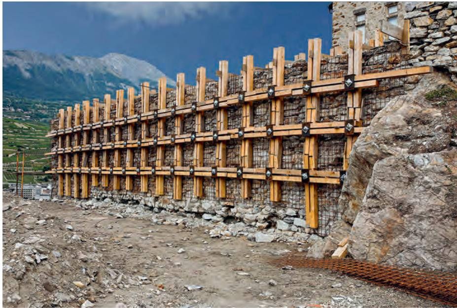
**FIG. 438** Les moellons disloqués serrés entre eux par le corset comme dans un « sac de noix » peuvent alors être manœuvrés en bloc et remis à la verticale par un ensemble de tendeurs situés en amont, sans que les positions archéologiques de la maçonnerie n'en soit affectées ; mur ouest de la terrasse 4. Photo Bernard Dubuis et Michel Martinez, 2009, CDC.
