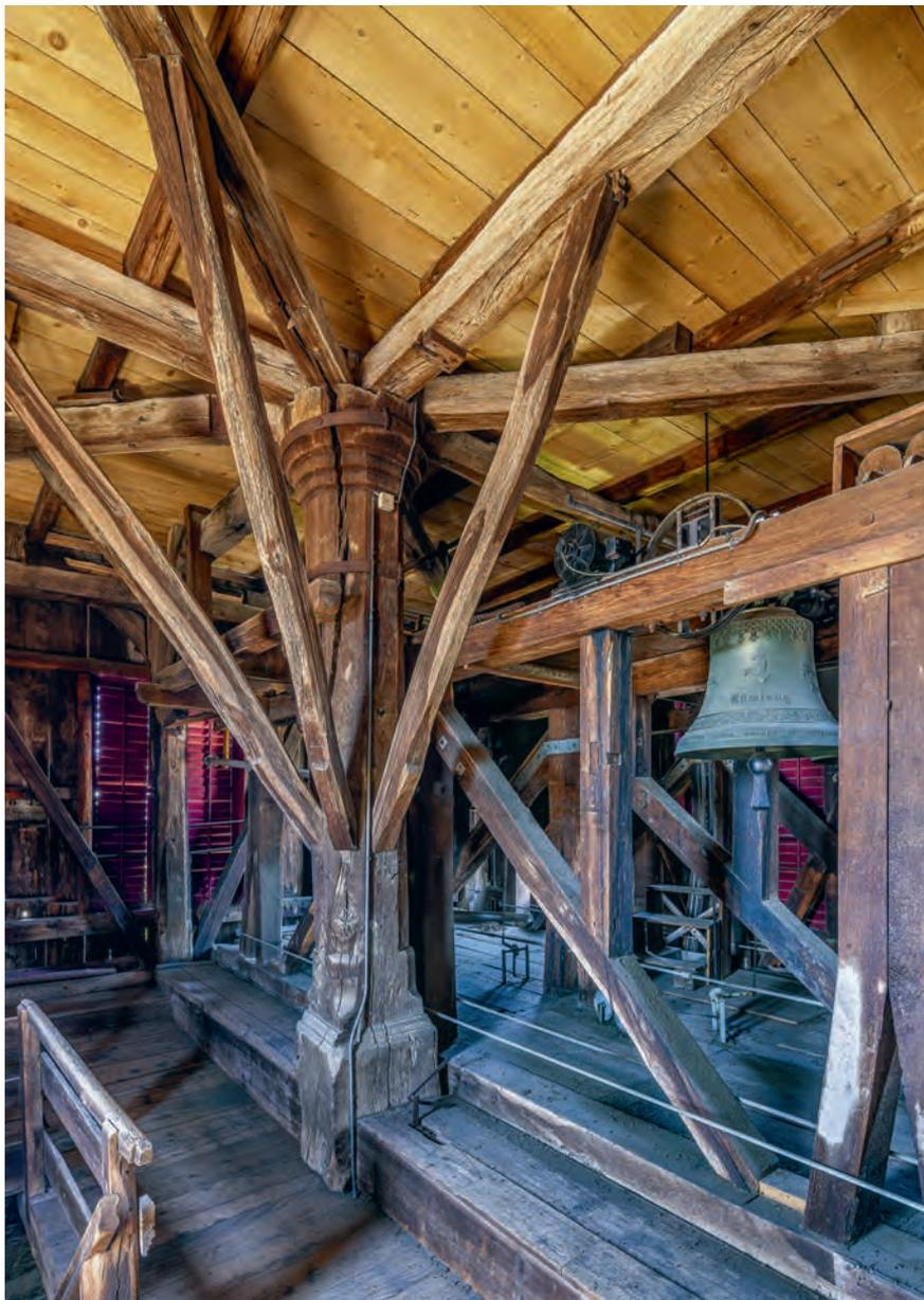
**ABB. 16** Rümli-Kirche, Kehlhofstrasse 3, Rümlang. Innenansicht des Glockengeschosses. In der Raummitte stützt eine mächtige Eichensäule mit Kopfstreben die rechtwinklig und diagonal angeordneten Bundbalken. Kirchtürme mit hölzernen Obergedäulen sind in der Region selten. Als weiteres Beispiel im Kanton Zürich sei die ref. Kirche Illnau genannt. Eine ähnliche Stützkonstruktion weist etwa der Wasserturm in Luzern auf. Foto Urs Siegenthaler, Zürich, 2022.
