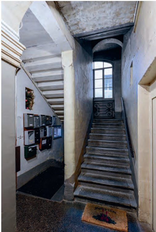
FIG. 85 Grand-Rue 16. Escalier rampe-sur-rampe de l'ancienne maison Vautrin, construite en 1722-1726. Photo Adrien Buchet, 2017, IMAHGe.
