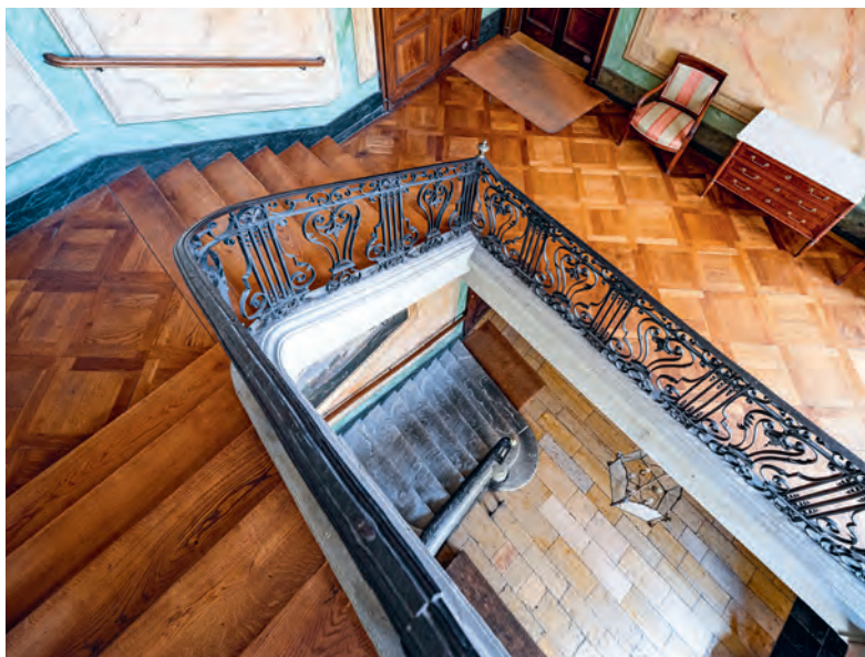
FIG. 267 Place du Grand-Mézel 4. Maison Cramer, puis Labat. Vue plongeante sur le grand escalier montrant sa volée de départ décalée par rapport à celle menant du premier au second étage. Photo Olivier Zimmermann, 2023, IMAHGe.
