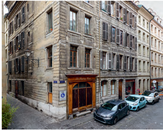
FIG. 69 Grand-Rue 16. Ancienne maison Vautrin, façade sur rue, augmentée de deux travées par l'adjonction du bâtiment d'angle recons- truit en 1787. Photo Adrien Buchet, 2017, IMAHGe.
