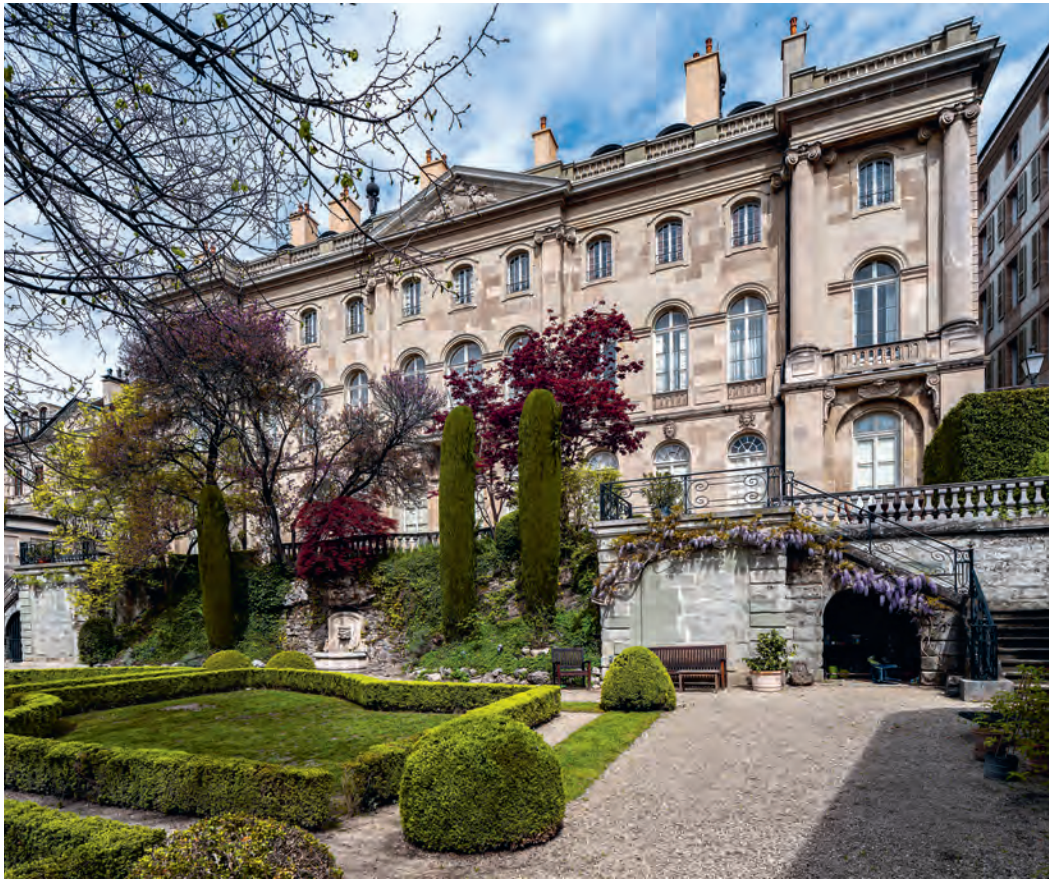
FIG. 223 Rue de la Cité 24. Hôtel Lullin-de Saussure. Façade sur le jardin vue depuis l'angle sud de la terrasse. Photo Olivier Zimmermann, 2023, IMAHGe.
