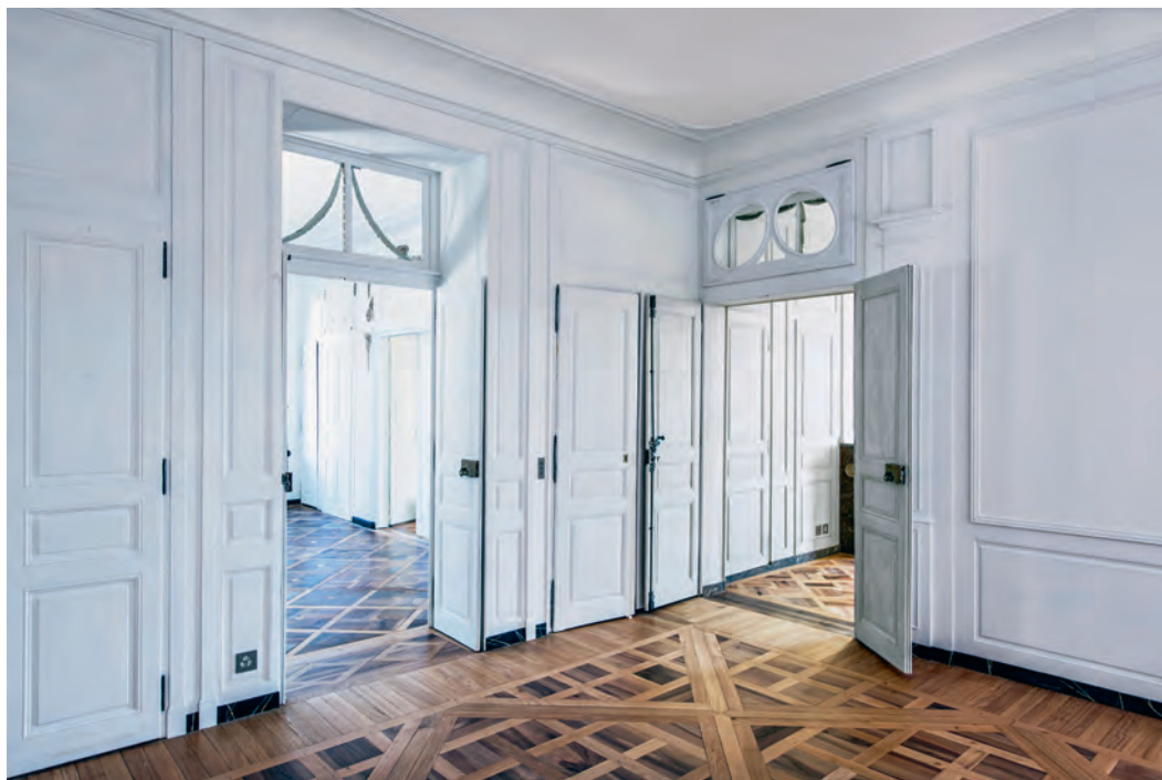
FIG. 378 Rue Beauregard 8. Immeuble Thellusson. Rez-de-chaussée supérieur, vestibule. La porte à gauche s'ouvre sur la salle à manger, celle à droite, sur le petit salon, lequel pouvait faire également office d'antichambre. Le parquet « Versailles » du vestibule et des autres pièces de l'appartement date des travaux de 2016. Photo Didier Jordan, 2016, OPS.
