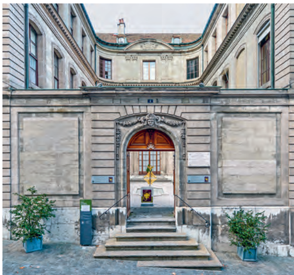
342 FIG. 342 Rue du Cloître 2-4. Maison Mallet. Grand portail sur la rue du Cloître. Photo Adrien Buchet, 2017, IMAHGe.
