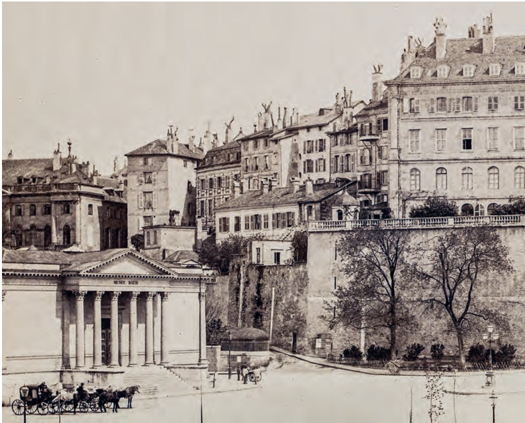
FIG. 268 Vue de la Tertasse depuis la place de Neuve, détail. Au-dessus du fronton du Musée Rath, on aperçoit l'ancien pavillon de jardin construit en 1769 pour accueillir le « cercle de la maison Labat ». Photo Auguste Louis Garcin, avant 1880. BGE [phot2op pl ne 09 a].
