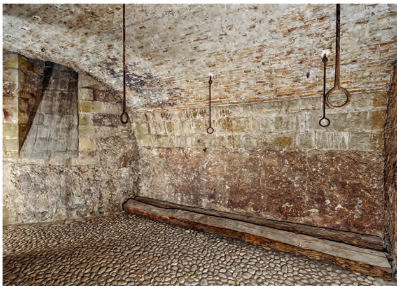
FIG. 323 Rue des Granges 8. Hôtel Naville-Boissier. L'une des caves de la maison avec sa voûte en berceau, construite en briques, et son sol revêtu de galets de rivière. Photo Thierry Wenger, 2018, coll. Ceux d'en face.
