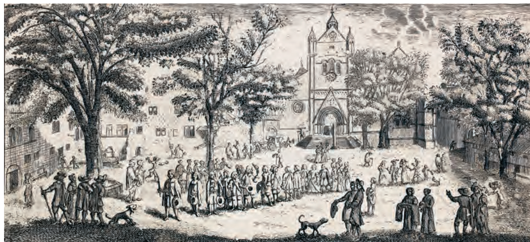
FIG. 339 François Diodati. Vue de la cour de Saint-Pierre, vers 1675. À gauche du temple, les maisons du cloître de Saint-Pierre, reconstruites au XV e siècle. BGE [vg 1096].
