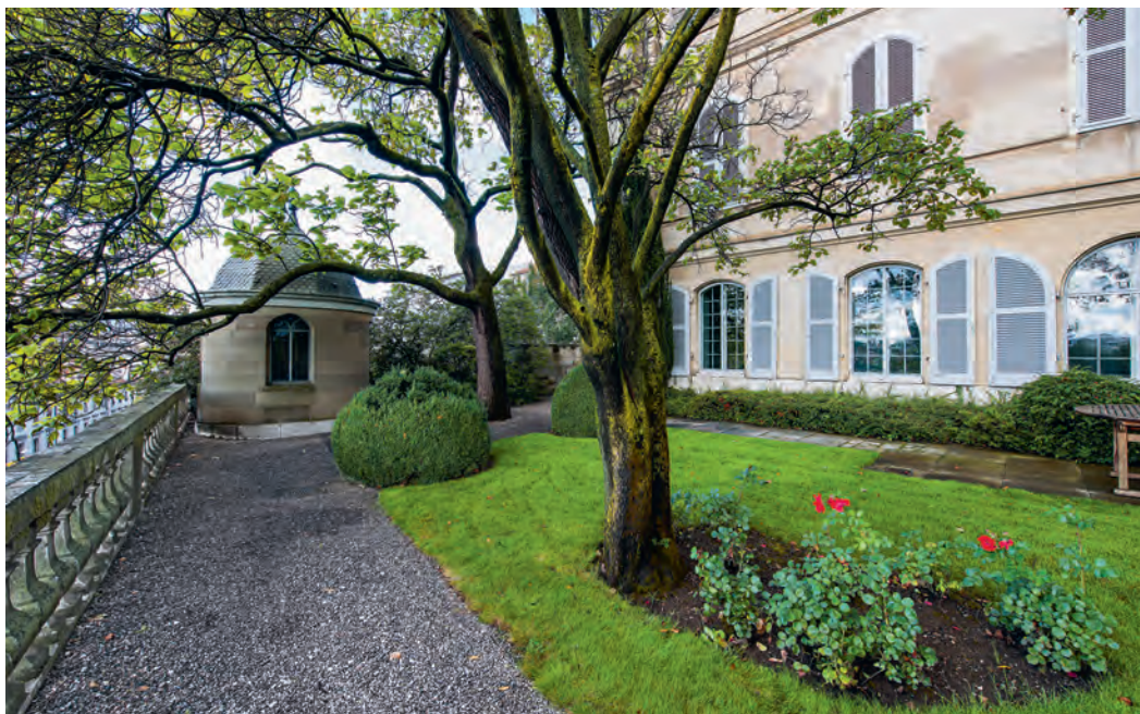
FIG. 290 Rue des Granges 2. Hôtel Sellon. Petit pavillon qui surmonte l'escalier en vis descendant vers la place de Neuve. On le voit déjà sur le dessin de Jean-Jacques Dufour FIG. 285 . Photo Olivier Zimmermann, 2012, OPS.
