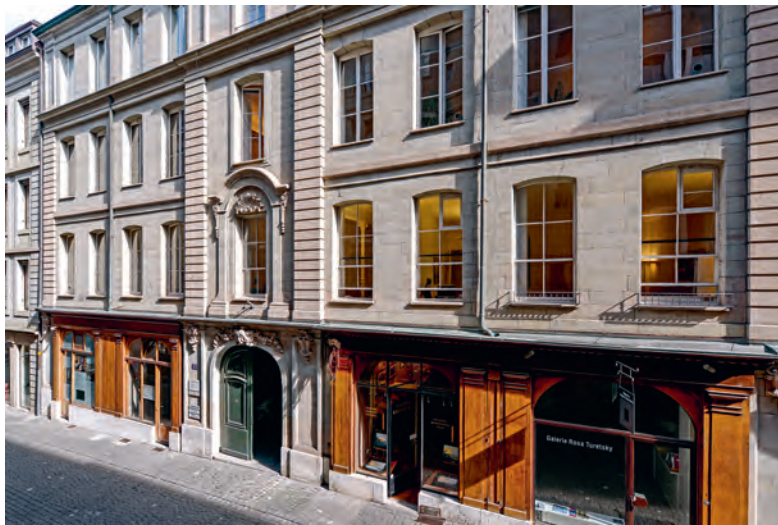
FIG. 67 Grand-Rue 25. Ancienne maison Cramer, façade sur rue. Photo Adrien Buchet, 2017, IMAHGe.
