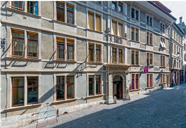
FIG. 31 Grand-Rue 39. Maison Calandrini. Le troisième étage a remplacé en 1786 un demi-étage coiffé d'une toiture couverte de tuiles creuses. Photo Adrien Buchet, 2017, IMAHGe.
