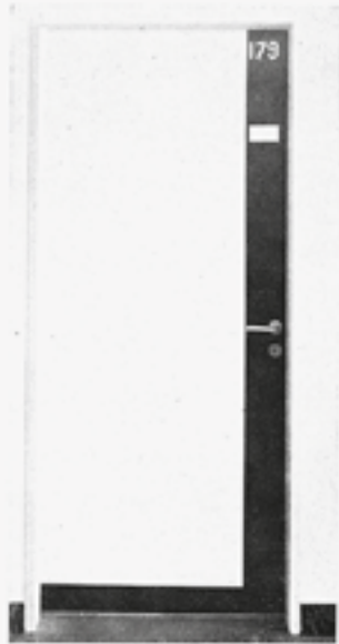
Normkölbe, Sperrholz, auf Eisenrahmen mit Gummidichtung schließend
