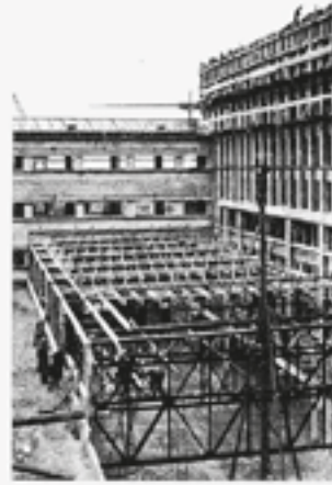
Eisenkollon des Lenzsaalträgers Rohbaufnahme
