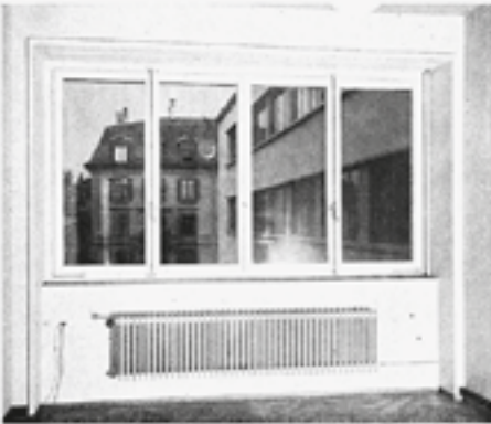
Holzfenster, Stahlradiatoren der Sauriswerke in Freiburg (Spezialmodell)
