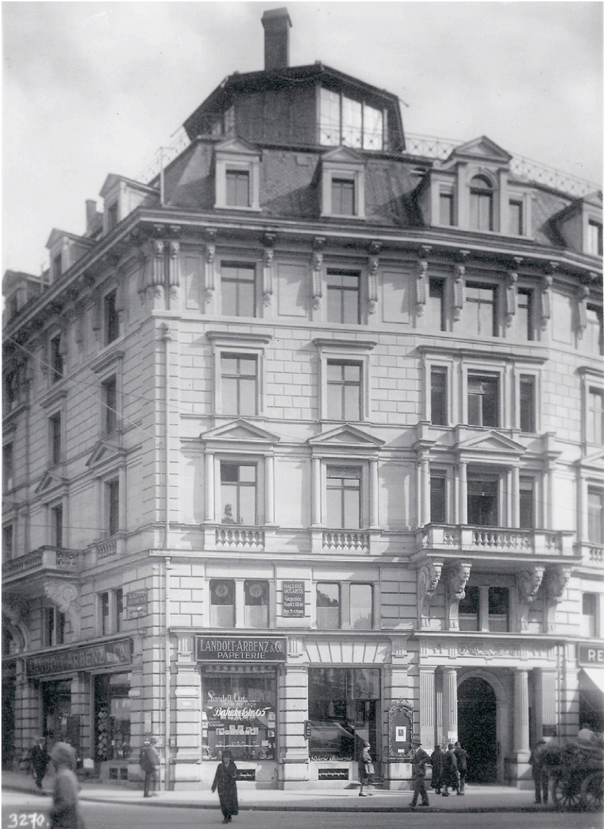
Abb. 33: Die Galerie Aktuaryus an der Bahnhofstraße 66 in Zürich. Foto: BAZ. 95
