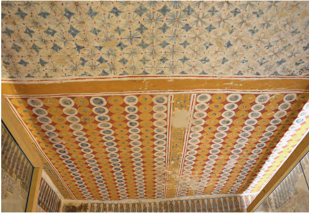
Abb. 131 TT 295 ( Djehutimose gen. Paroy ). Die Decke ist durch gelbe Streifen, von denen einige eine Inschrift enthalten, in verschiedene Bereiche getrennt. Die zentrale Achse vom Eingang in den zweiten Raum wird durch ein eigenes Muster (hier im Vordergrund) hervor-gehoben.
