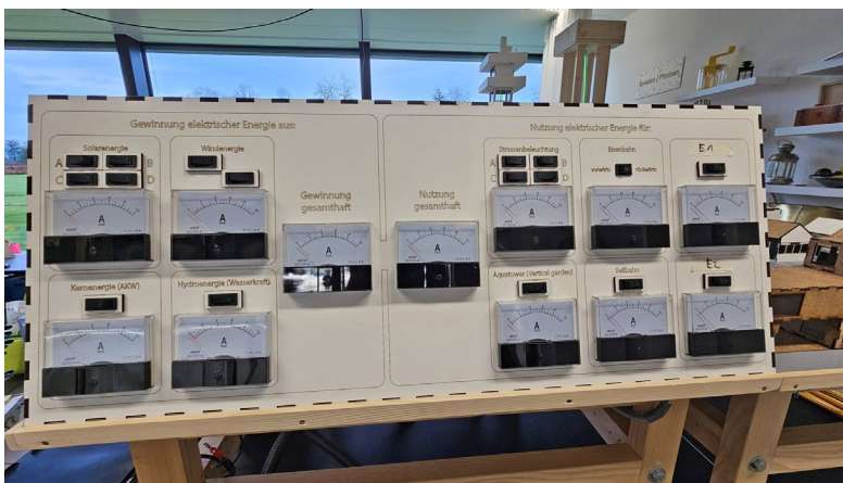
Abbildung 2: Instrumententafel der Steuerzentrale des Elektrizitäts-Übertragungsnetzes
