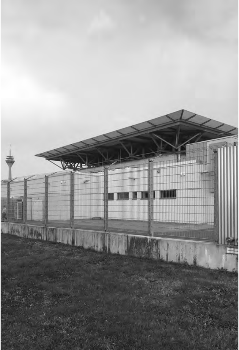
Abbildung 1: Oberlandesgericht Düsseldorf, Außenstelle Kapellweg, Sondergebäude für Verfahren im Bereich Staatsschutz, © Klosterkamp 2019
