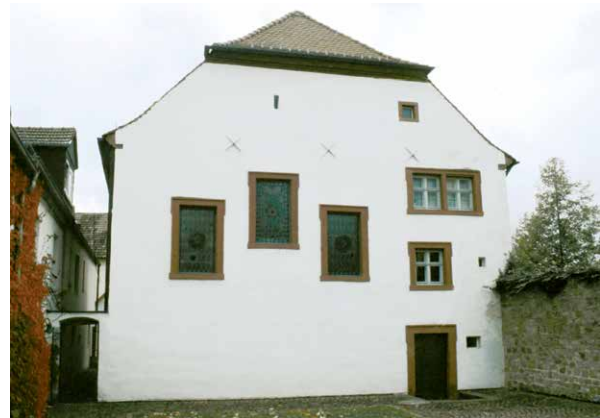
Fig. 3. Die Synagoge von Veitshöchheim vor (© Ulrich Wagner 1987) und nach der Restaurierung (© Hans-Peter Süß).
