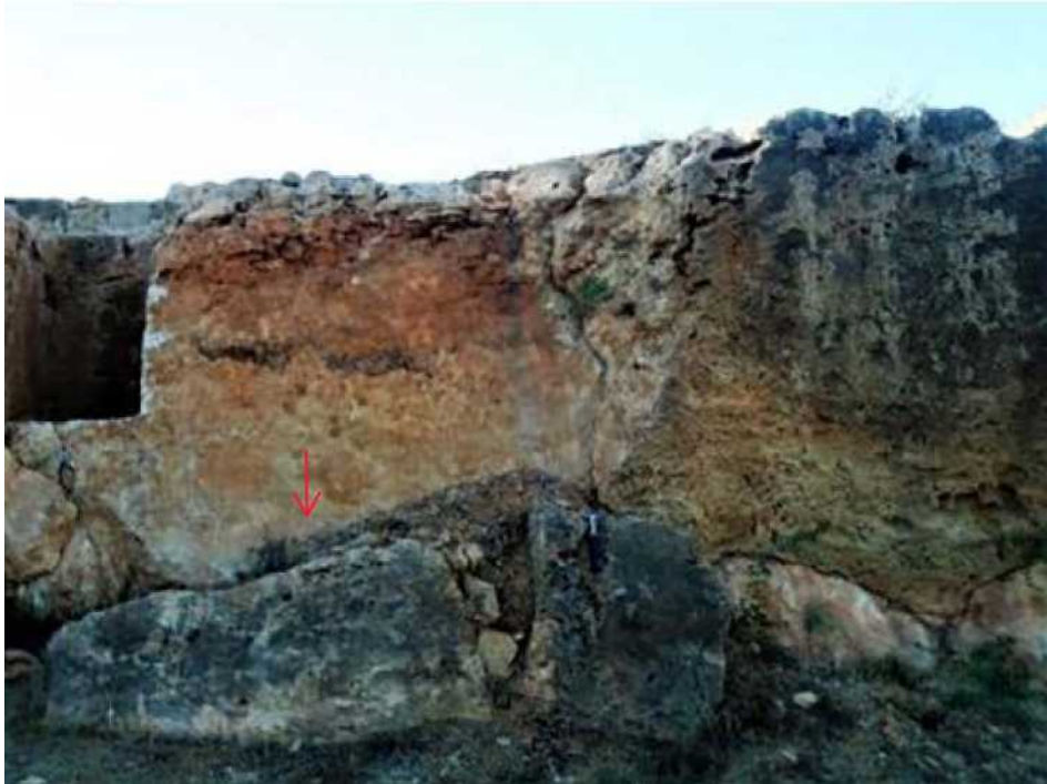
Εικόνα 8. Αποκόλληση τεμάχους στην Νότια πλευρά εξωτερικά Τάφου 3
