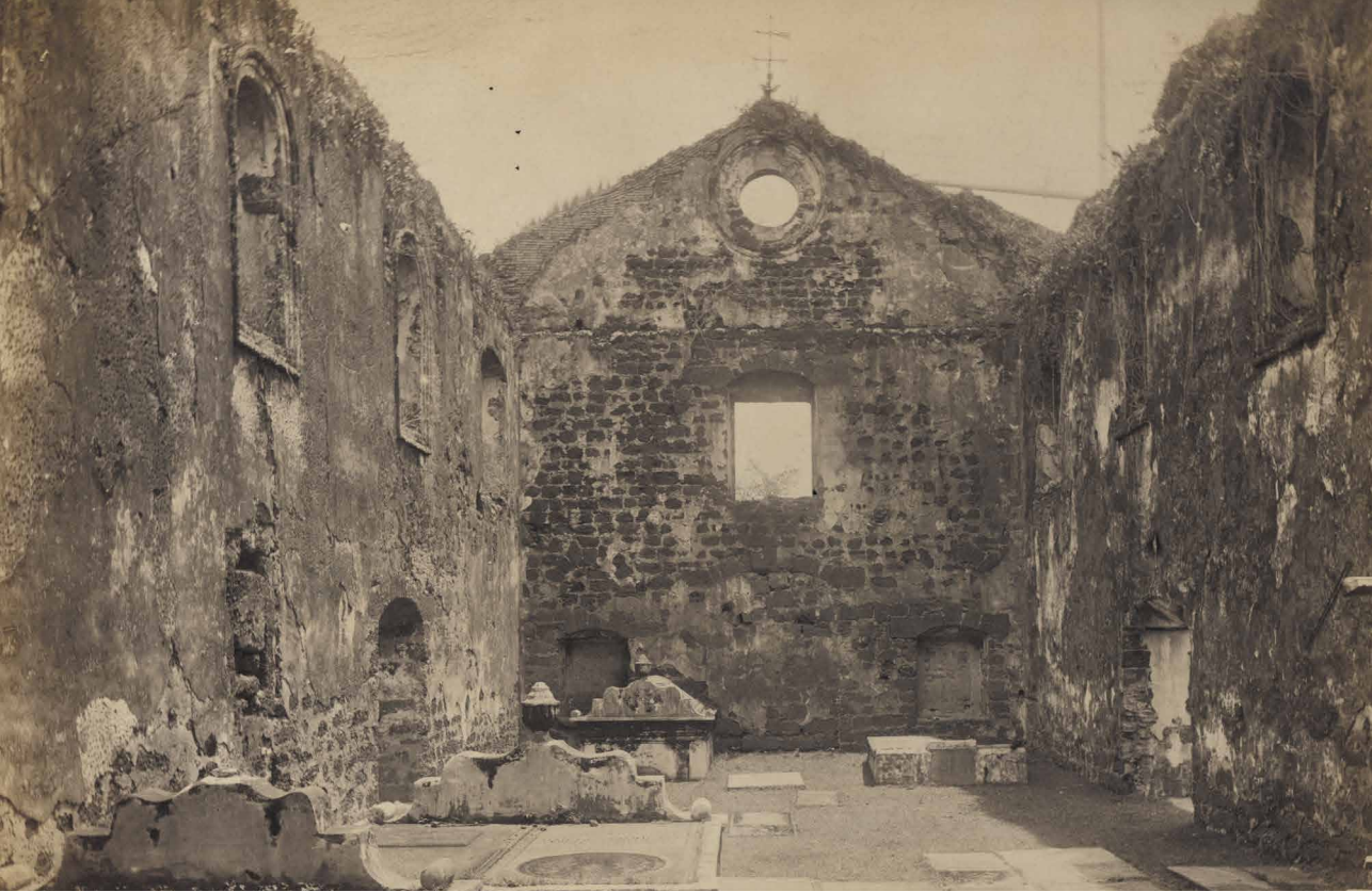
Ruïne van de Portugese kerk Nossa Senhora do Onteiro te Malakka, circa 1895.
