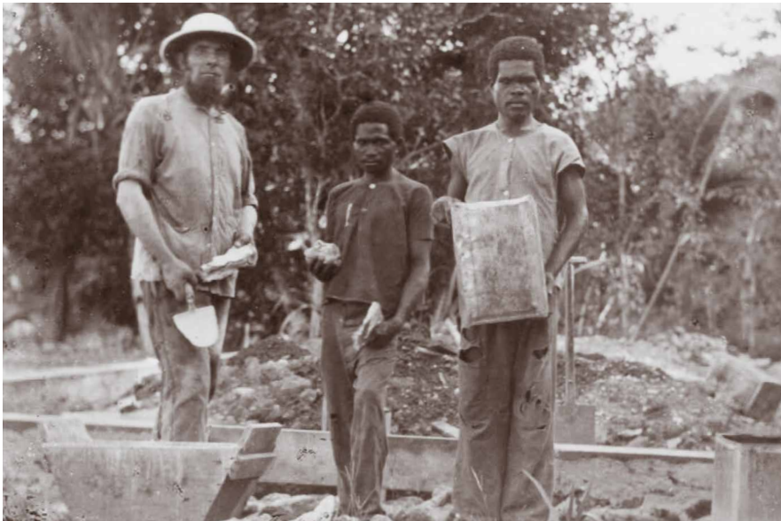
10.3 'Jongens' helpen Van Balen met het metselen van een fundering voor de school te Windesi.
