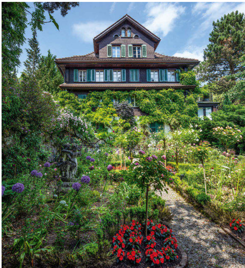
4 Das klassizistische Wohnhaus ist ein vollständig verschindelter Blockbau mit Walmdach, allseitigen Lukarnen, regelmässiger Fenstereinteilung und einer umlaufenden Vordachreihe. Als Vorbild insbesondere im Hinblick auf die Dachform und den französischen Barockgarten soll das Schorno-Haus im Oberen Feldli in Schwyz gedient haben. Foto Georg Sidler, Schwyz, 2023.
