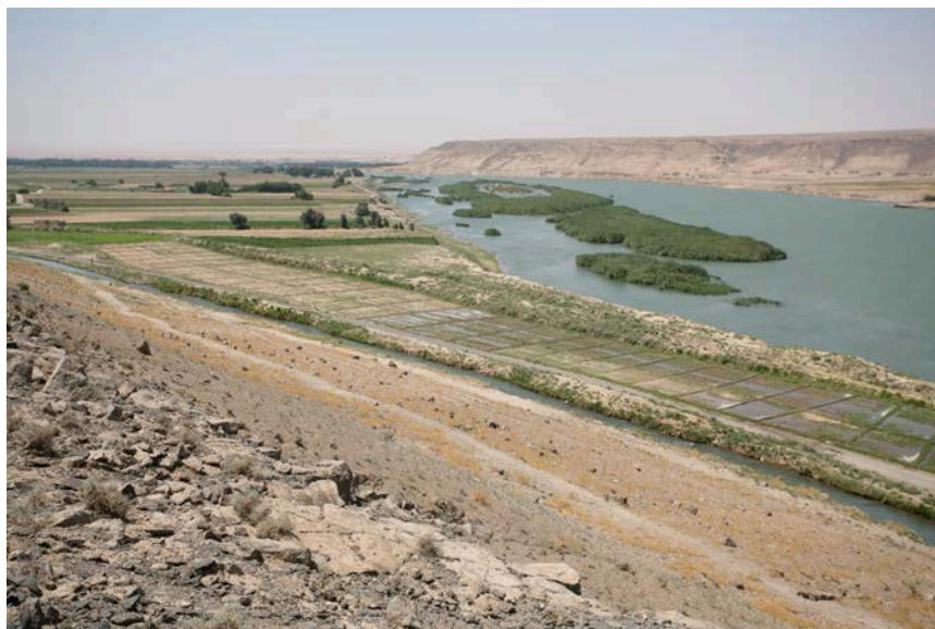
Fig. 6: Le canal Sémiramis à la sortie du verrou de Hanuqa (photo E. Taboada, PAMES)
