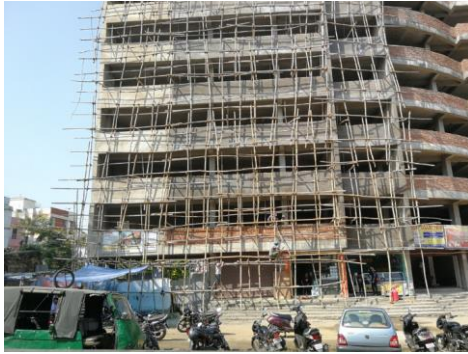
Abb. 5: Gerüst in Nordindien
