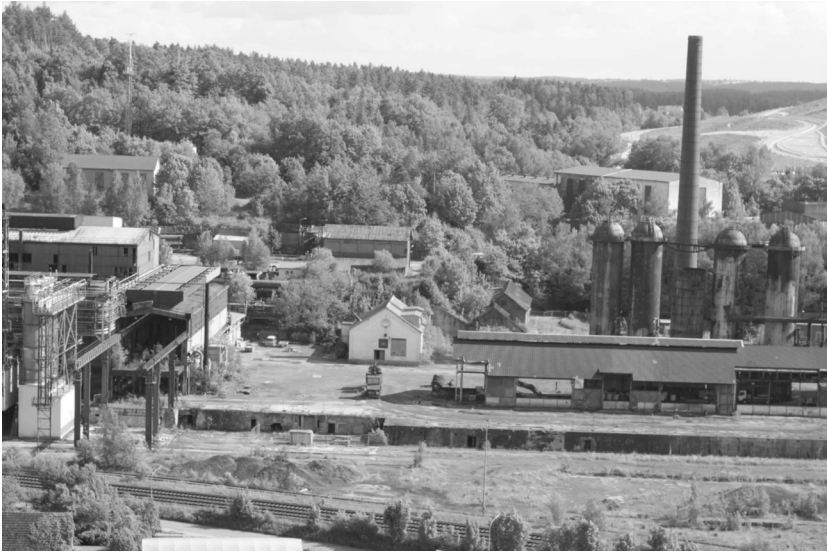
Abbildung 1: Blick auf die Maxhütte
