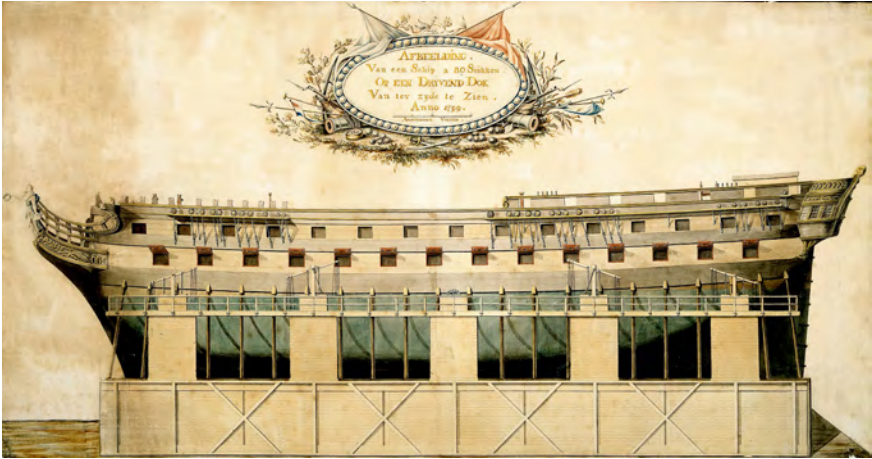
Abb. 9: Kriegsschiff im Schwimmdock. Das Dock besteht aus fünf Sektionen, die untereinander durch kreuzweise angeordnete Bohlen verbunden sind. Auf jedem Ponton befinden sich zwei Aufbauten, auf denen Pumpen angeordnet sind. Die Aufbauten sind durch eine Arbeitsgalerie verbunden. (Collection Maritiem Museum Rotterdam, T237)
