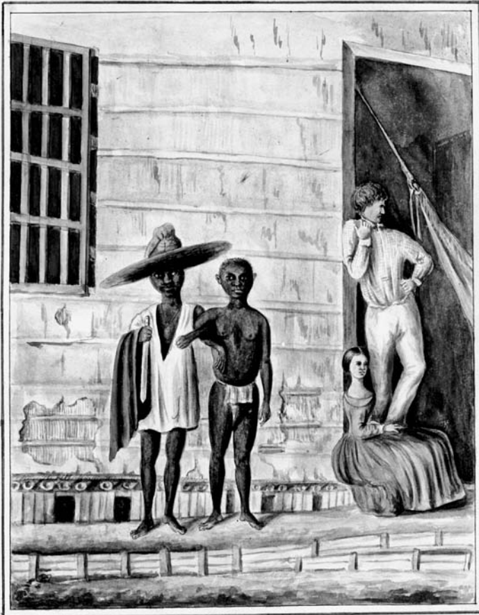
Aspecto exterior de las casas de Nóvita
