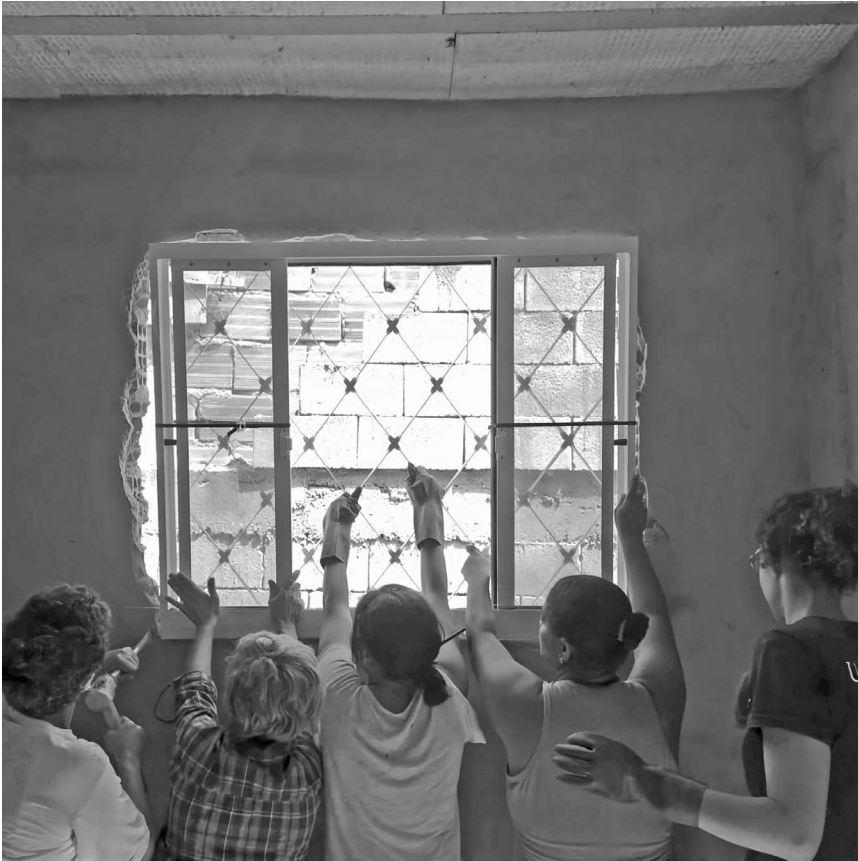
Figure 7.5 Window fitting in the workshop of Arquitetura na Periferia of Carina Guedes. Source: Arquitetura na Periferia – Carina Guedes de Mendonça (2013) .
