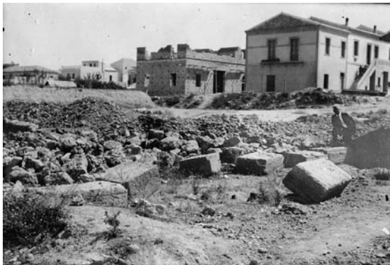
Fig.17.5 Blocchi squadrati di arenaria messi in luce durante la costruzione della stazione delle Calabro Lucane (Archivio fotografico Soprintendenza Archeologica della Calabria).
