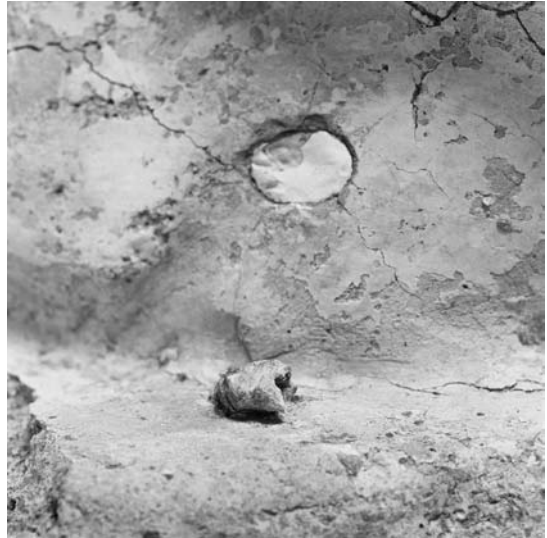
Fig. 13.10 Particolare del perno che fissava originariamente la lastra di base all'interno di un coppo.
