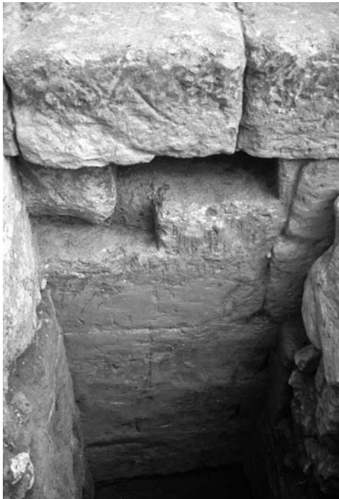
Fig. 26.18 Il prospetto della fondazione delle mura monte-mare di età arcaica nel loro lato interno.
