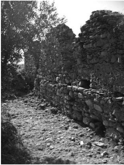
Fig. 10.3 Muro meridionale dell'edificio di culto in località S. Marco.
