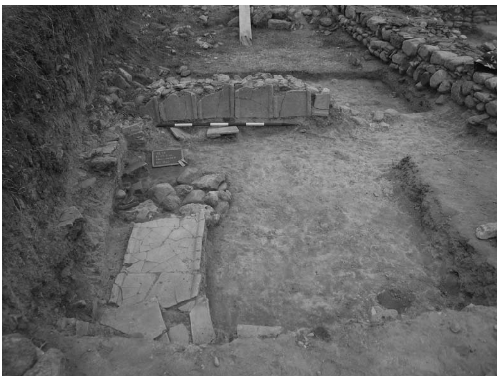
Fig. 6. 34 La struttura muraria USM 1083 con le tegole paraguttae .
