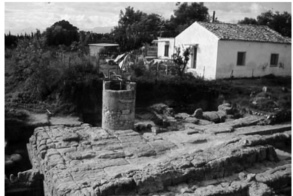
Fig. 26.6 Panoramica della torre; in alto a ds. i saggi presso l'angolo sud-ovest della torre e entro l' emplecton delle mura monte-mare.
