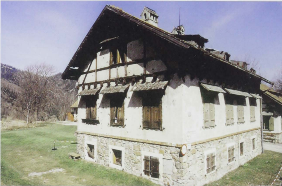
319 Das in Renovierung befindliche Waschhaus des Südbahnhotels im Meiereigelände, 2003. Deutlich sind auf der Fassade noch die russischen Einschüsse zu sehen
