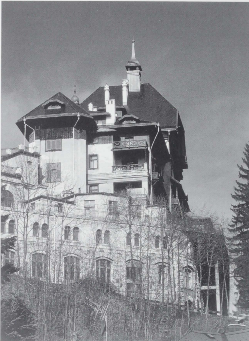
255 Südbahnhotel: Der spätere »fortifikatorische« Fundamentbau der Untergeschoße, ab 1908
