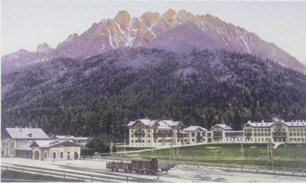
72 Toblach/Dobbiaco: Bahnhof und Südbahnhotel vor den Sextener Dolomiten
