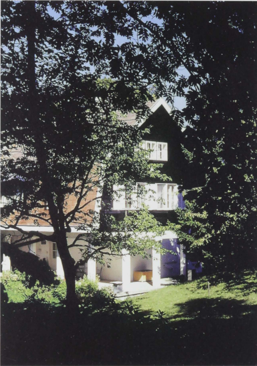
194 Breitenstein: Villa Mahler/Werfel in Ortbof, Zustand 2004
