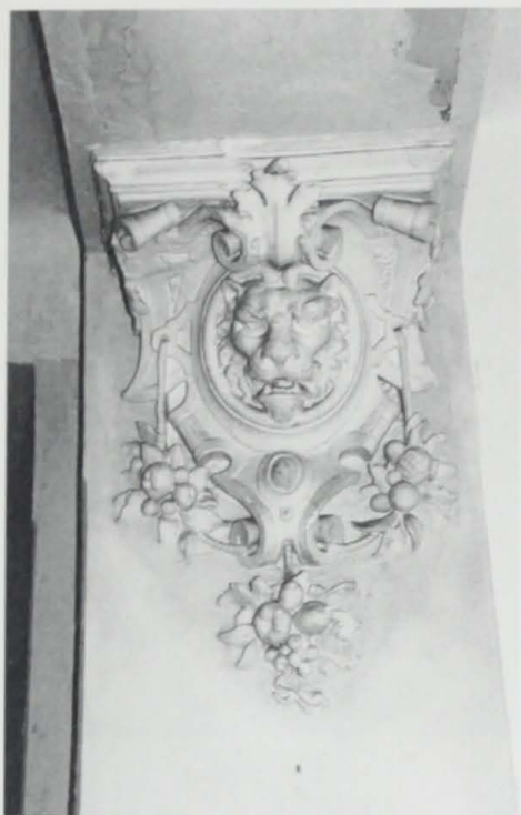
95 Südbahnhotel Toblach: Stuckdekoration
