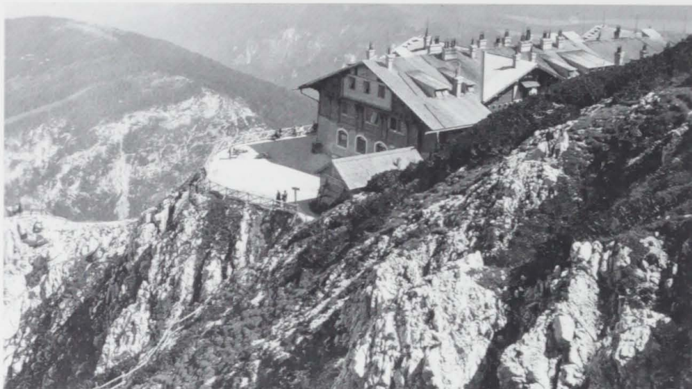
57 Eisenbahnhotel Hochschneeberg (1.800 m)
