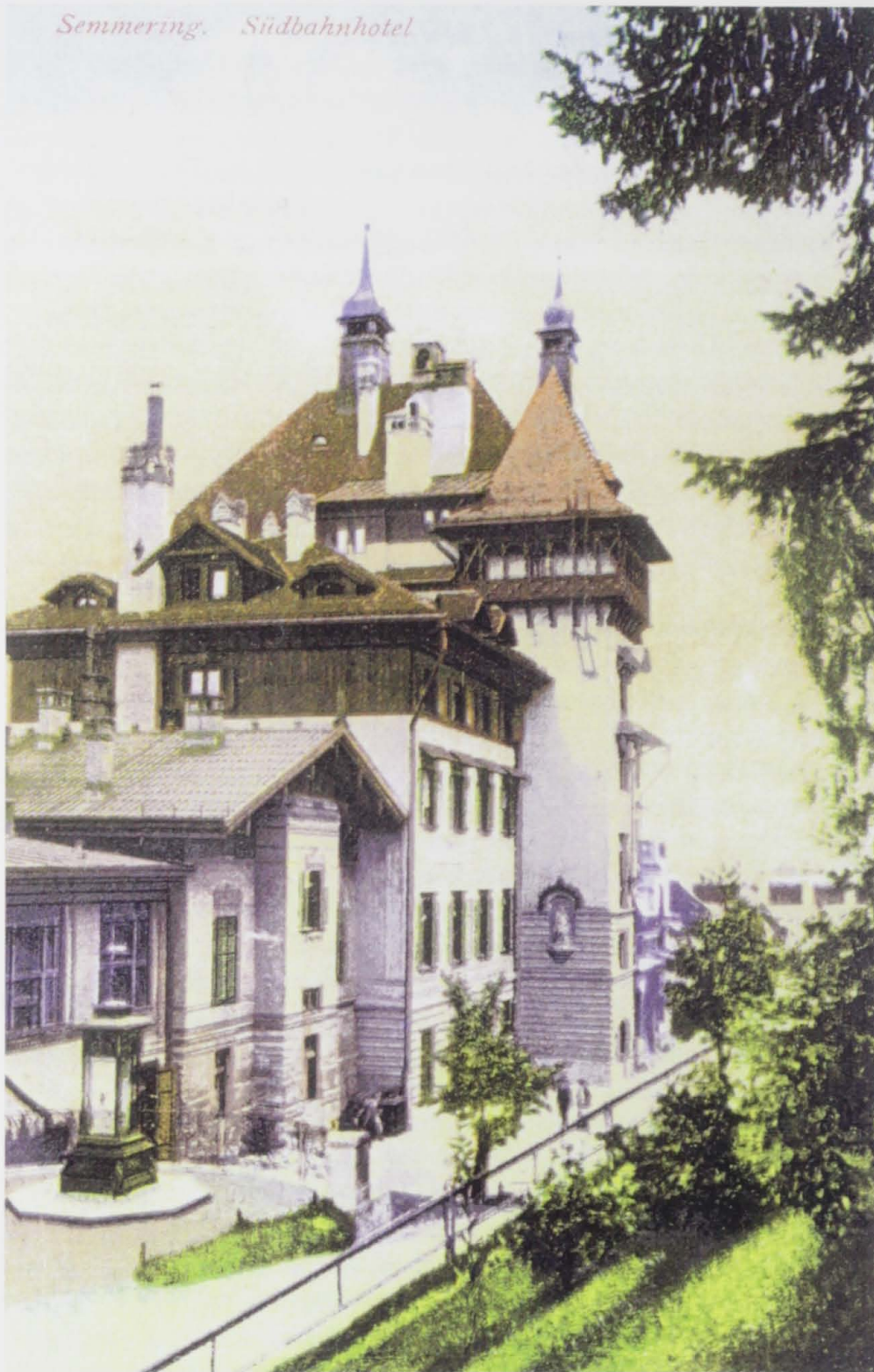
266 Südbahnhotel: Kastellartiger Turm mit Hl. Florian am Turmfuß. Dahinter verbirgt sich das Treppenhaus mit Lift. Im Vordergrund das Wetterhaus an seinem Ursprungsplatz, ca. 1908
