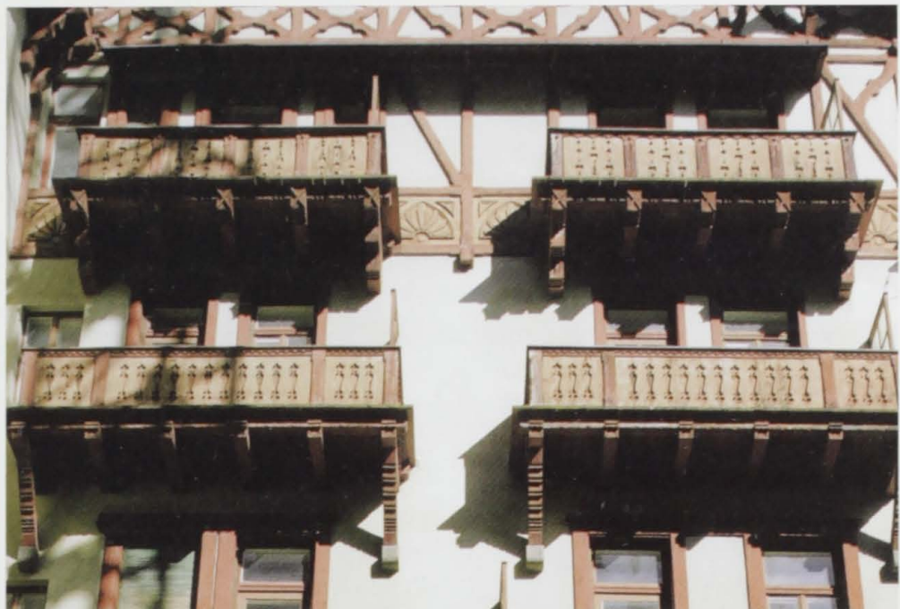
85 Südbahnhotel Semmering: Holzdekor der bergseitigen Fassade, Zustand 2005. Die für die Südbahnhotels typischen Beton-Konsolen finden sich in Toblach und am Semmering
