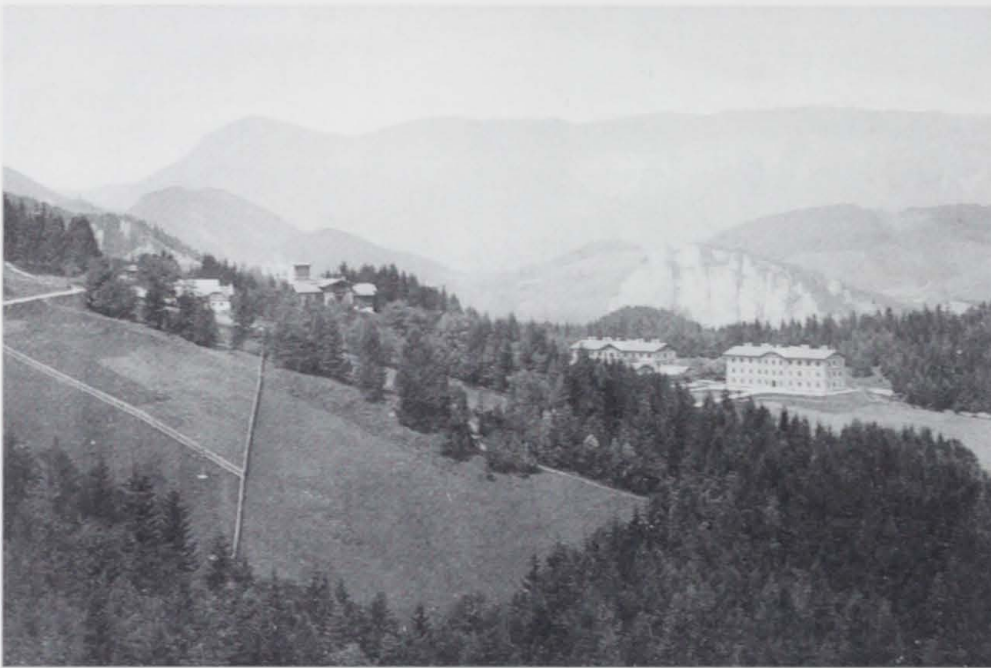
175 Links: Die ursprüngliche Villa von Bahndirektor Karl Prenninger (spätere Villa Alber), davor der Polleros-Hof. Rechts: Die Touristenhäuser der Südbahn
