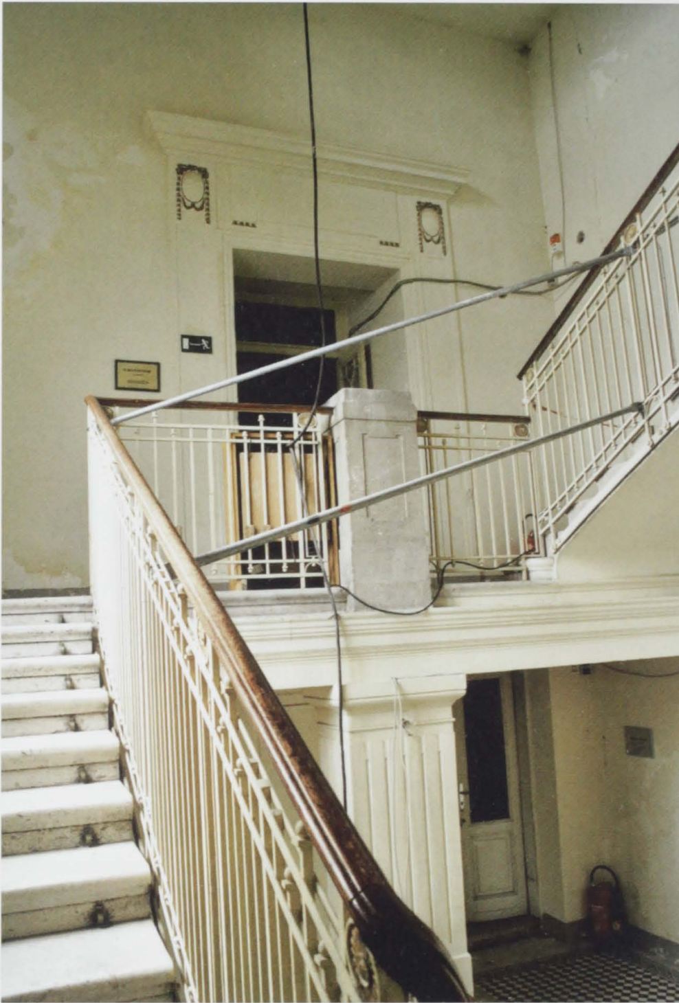
285 Südbahnhotel: Neuer Stiegenaufgang im Speisesaalzubau von 1913
