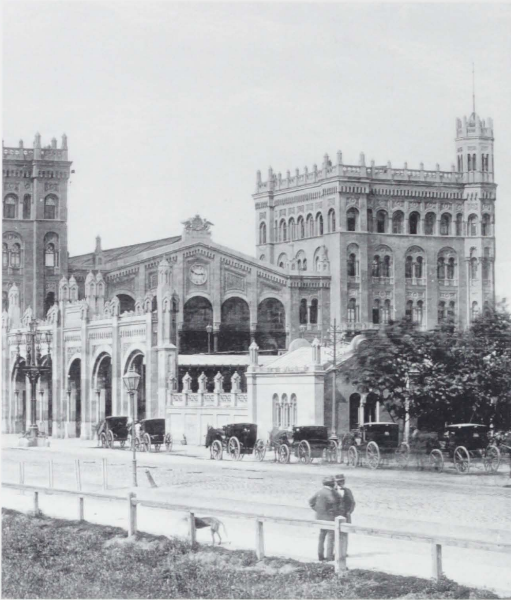
52 Wien: Ehemaliger Nordbahnhof
