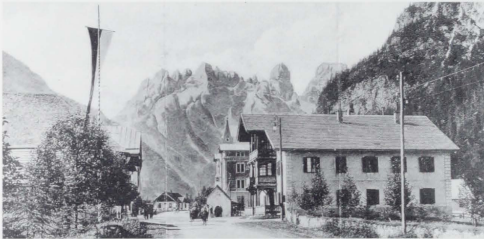
103 Landro/Südtirol: Ehemalige Hotelsiedlung Landro im Höhlensteintal um 1900. Heute existiert davon nur mehr die Kapelle (Bildmitte), alles andere wurde während des Ersten Weltkrieges aus strategischen Gründen geschliffen
