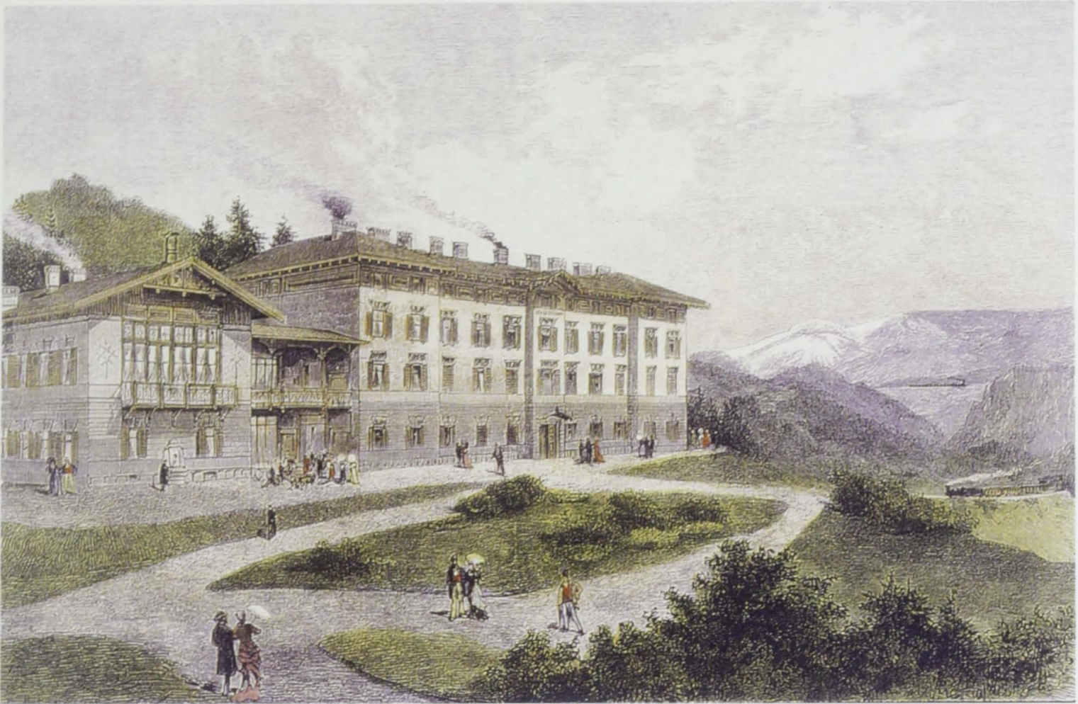
150 Ansicht des 1. Südbahnhotels am Semmering, 1882
