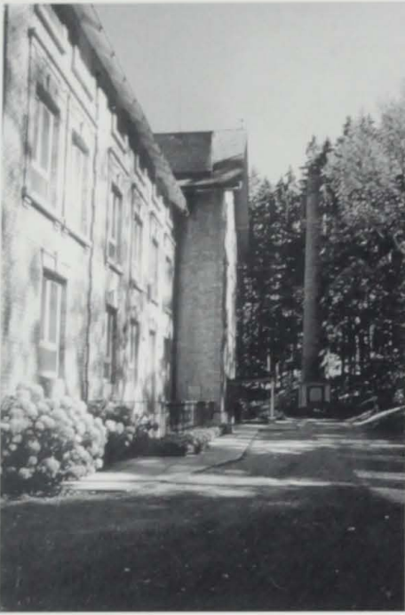
169 Semmering: Dampfwäscherei des Südbahnhotels. Im Hintergrund der Schornstein des ehemaligen Kesselhauses (1906/08)
