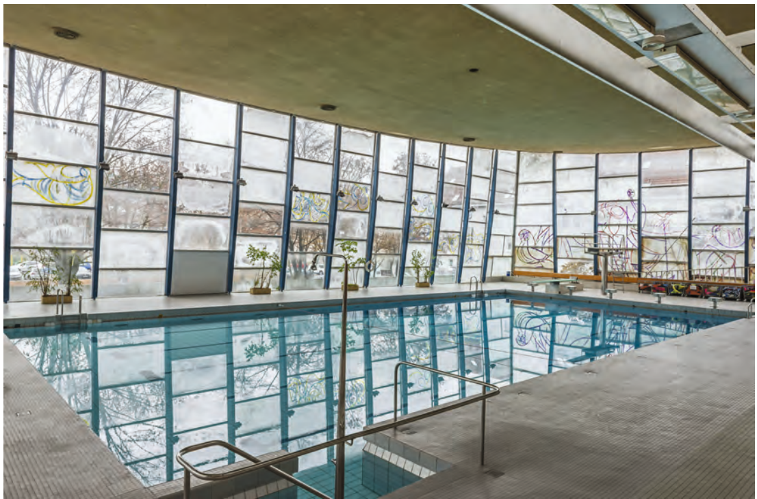
6 Milchig-trübes Erscheinungsbild der Glasfassade, Innenansicht von 2014/15.
