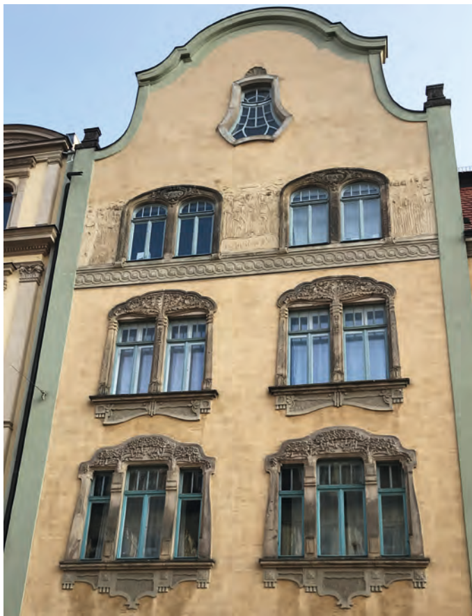
1 Fassade eines Hauses um 1900 in der Herzog-Max-Strasse, Bamberg, mit historischer Verglasung.
