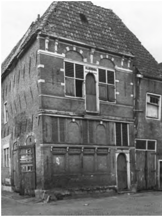
2a und 2b Fotografische Dokumentation eines Hauses in der Margaretenstrasse 21 im Stadtteil Linn in Krefeld in Deutschland, vor und nach der Restaurierung. Die Konstruktion, Platzierung und Grösse der Fenster wurde massgeblich verändert.
