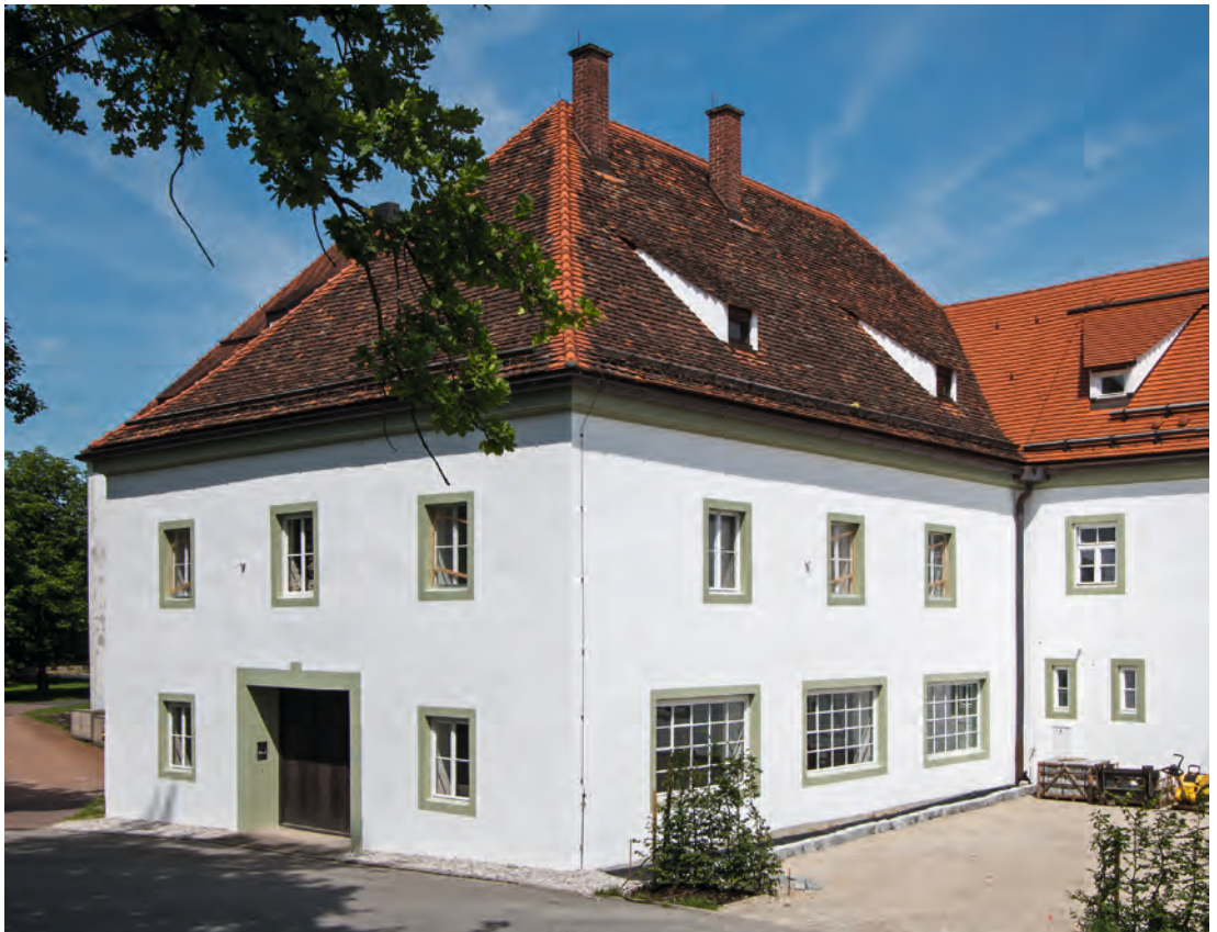
3 Die Fassade der Alten Schäfllerei in Benediktbeuern wird, wie viele andere Denkmalfassaden, von verschiedenen Fenstertypen geprägt.
