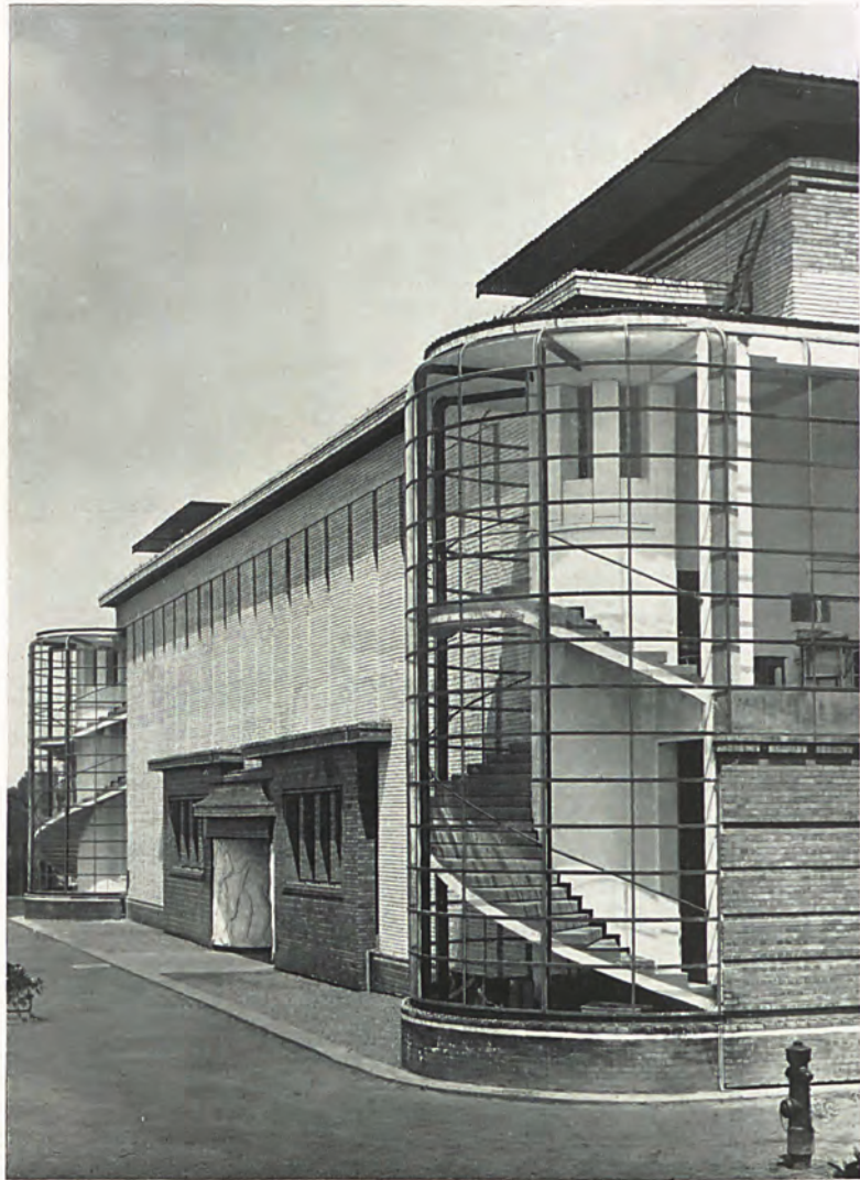
Abb. 2. Walter Gropius. Bürohaus-Glastürme. Erbaut auf der Deutschen Werkbund-Ausstellung in Köln 1914. Die seitlichen Treppenhäuser sind in großen Glaszylindern sichtbar gemacht und stehen in einem wirkungsvollen Widerspruch zu dem sonst geschlossenen Baukörper.
