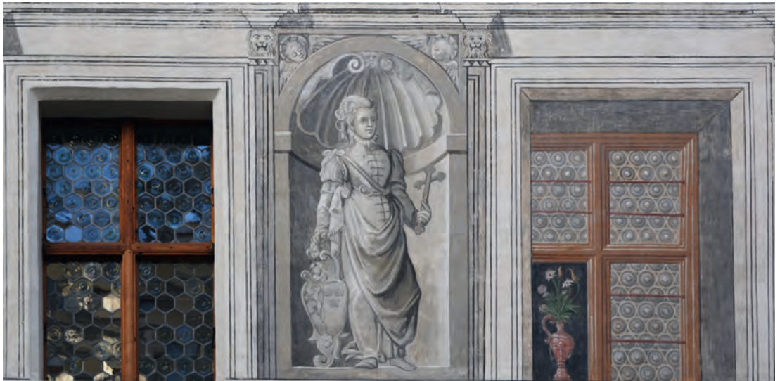
3 Reale und gemalte historische Fenster im Vergleich. Innsbruck, Schloss Ambras, 1570–1583, 1612–1855 als Kaserne genutzt.
