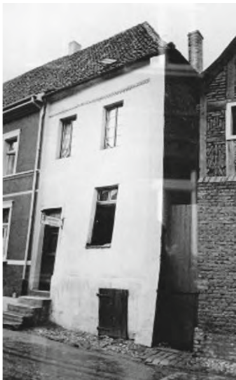
1a und 1b Fotografische Dokumentation eines Hauses in der Nieuwe Noord 45 der niederländischen Stadt Horn vor und nach der Restaurierung. Die Konstruktion, Platzierung und Grösse der Fenster wurde massgeblich verändert.
