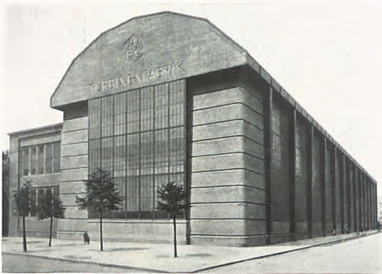
Abb. 4. Peter Behrens. Turbinenhalle der A. E. G. 1909. Dieses Bauwerk brachte zum ersten Male eine sinnvolle architektonische Behandlung der Materialien Eisen, Glas und Beton.
