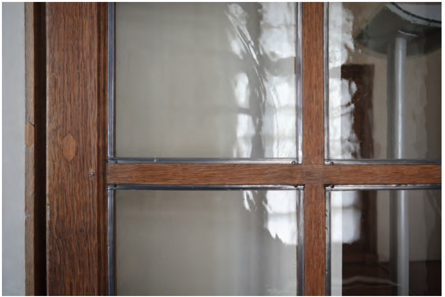
7a und 7b Neues Schloss Schleissheim, Fenstertüren um 1709 und Detail mit Bleiruten.
