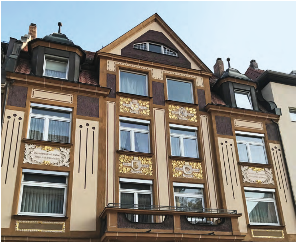
2 Fassade eines Hauses um 1900 in der Herzog-Max-Strasse, Bamberg, mit neuen modern geteilten Alufenstern.
