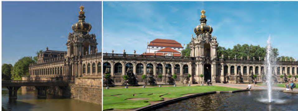
1 Ansichten des sog. Dresdner Zwingers: Pavillongruppe der wallseitigen Bogengalerie sowie Graben- und Hofseite der Langgalerie samt Kronentor, erbaut 1710–1719 nach Entwürfen von Matthäus Daniel Pöppelmann.
