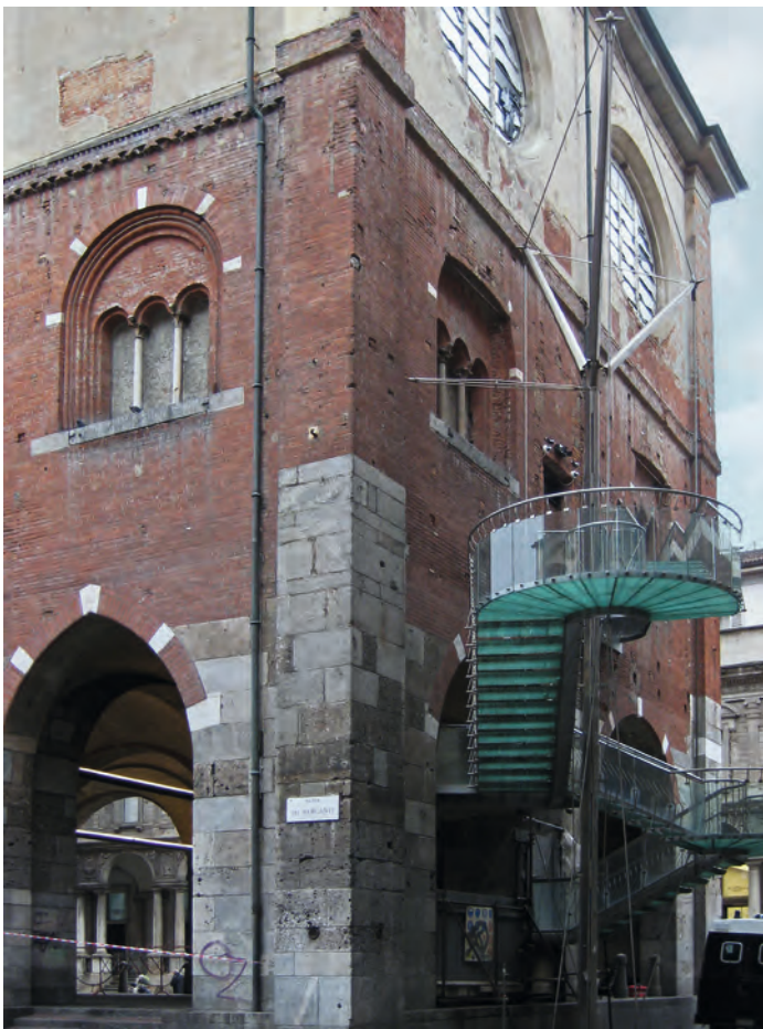
5 Mailand, Palazzo della Ragione, Fluchttreppe, Marco Dezzi Bardeschi, 1999; Gesamtrenovation des Gebäudes 1984–1992.
