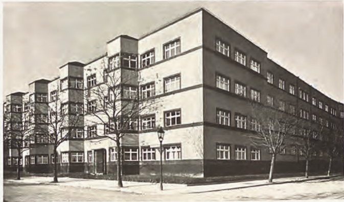
Mietshausblock Heiligendammer-Doberaner Straße-Crampasplatz zu Schmörgendorf 3-4 und 5-Zimmerwohnungen. Fronten Kiesputz, Fenstereinfassungen, Brüstungsgesimse und Eingänge in Kaltglasursteinen. Baujahr 1926/27
