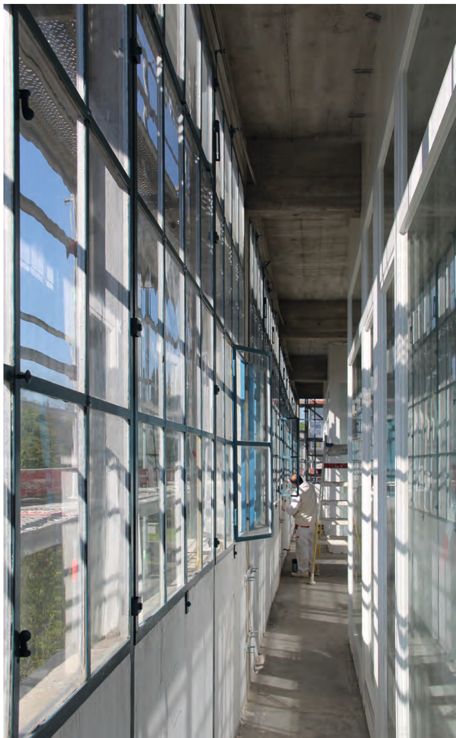
4 Fabrikgebäude in der Bat'a-Kolonie, Möhlin, im Kanton Aargau, errichtet 1934/35 nach Plänen des Bat'a-Baubüros in Zlin, umgebaut und ungenutzt zu Wohnungen 2015–2016.
