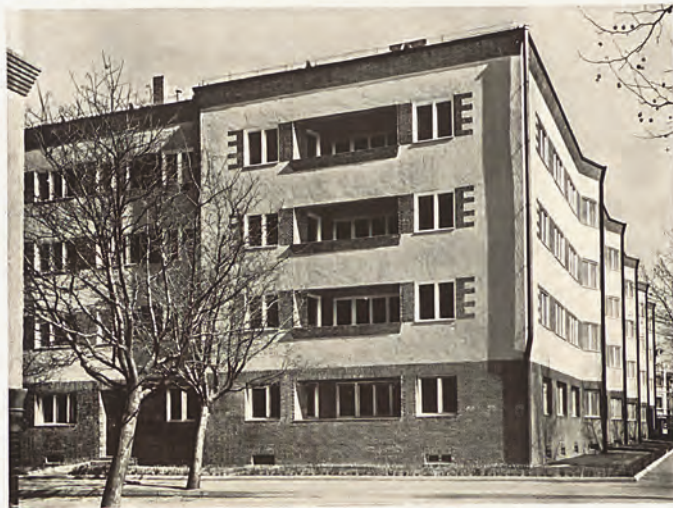
Mietshausblock Doberaner-Heiligendammer-Misdroyer Straße zu Schmörgendorf 3- und 4-Zimmerwohnungen. Fronten, Erdgeschoß, übrige Fensterpfeiler sowie Hauptgesims in Klinker kleinen Formats. Flächen Kiesputz. Baujahr 1926/27
