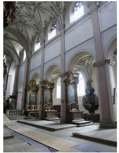
3 Bamberg Klosterkirche St. Michael, Langhaus Südseite mit Fenstern, Zustand ab ca. 1720.
