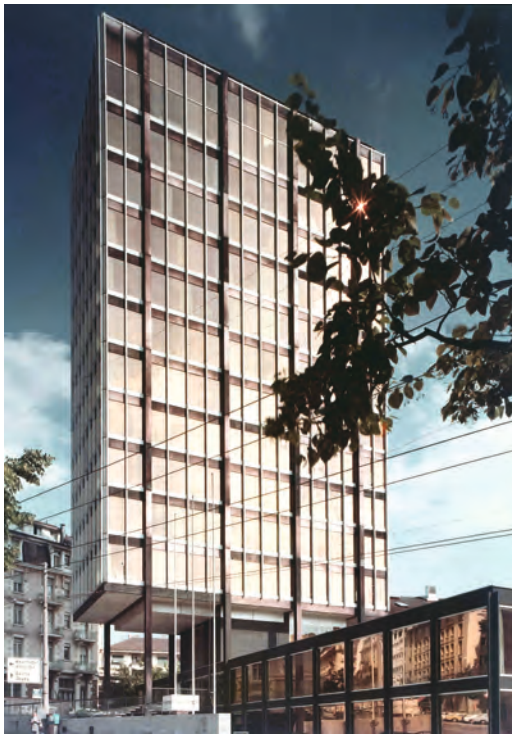
5 Tour des Imprimeries réunies, Jean-Marc Lamunière architecte, 1964, Lausanne, état à l'achèvement des travaux.
