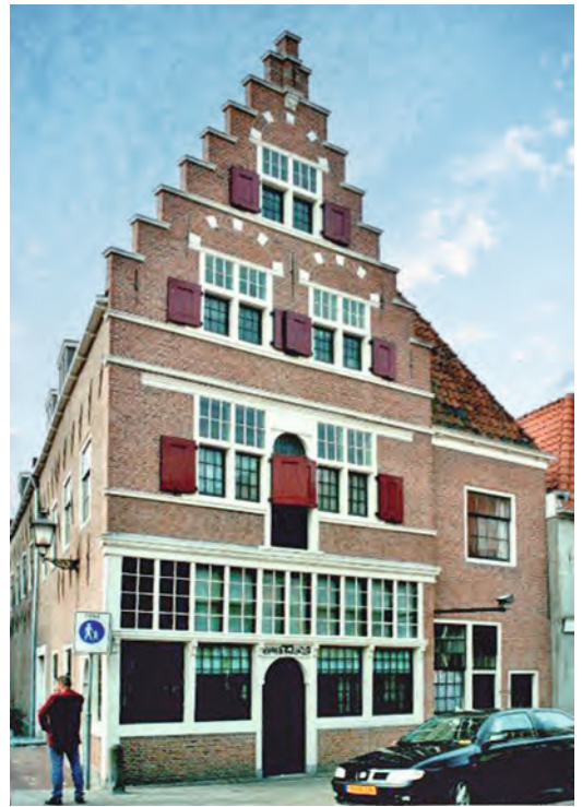
2a und 2b Fotografische Dokumentation eines Hauses in der Margaretenstrasse 21 im Stadtteil Linn in Krefeld in Deutschland, vor und nach der Restaurierung. Die Konstruktion, Platzierung und Grösse der Fenster wurde massgeblich verändert.
