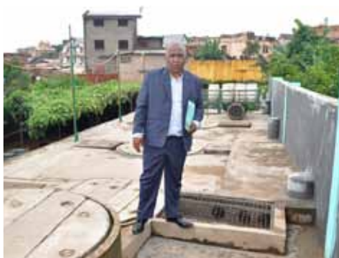
Station de traitement par réacteurs anaérobies à biogaz à Madagascar.
