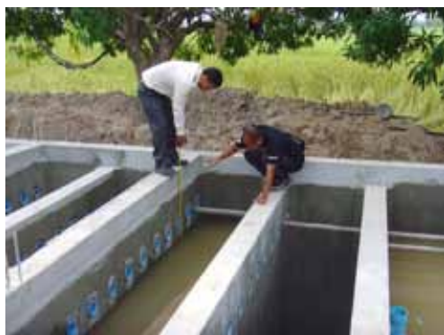
Réacteur anaérobie à chicanes en construction au Cambodge.
