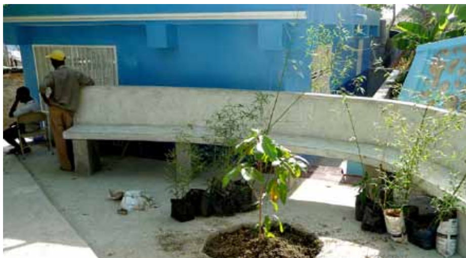
Aménagement de la place à côté du bloc sanitaire du quartier Baillergeau à Port-au-Prince (Haïti).
