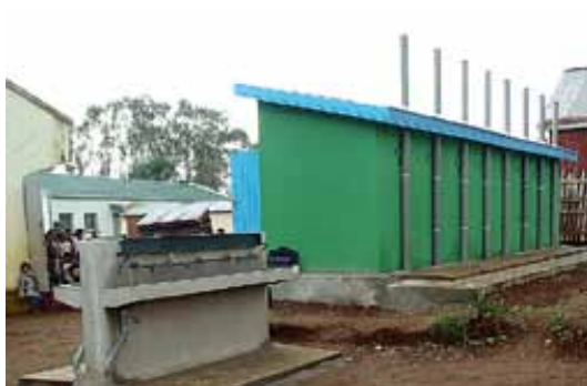
Bloc sanitaire scolaire avec dispositif de lavage des mains à Ambohibary (Madagascar).
