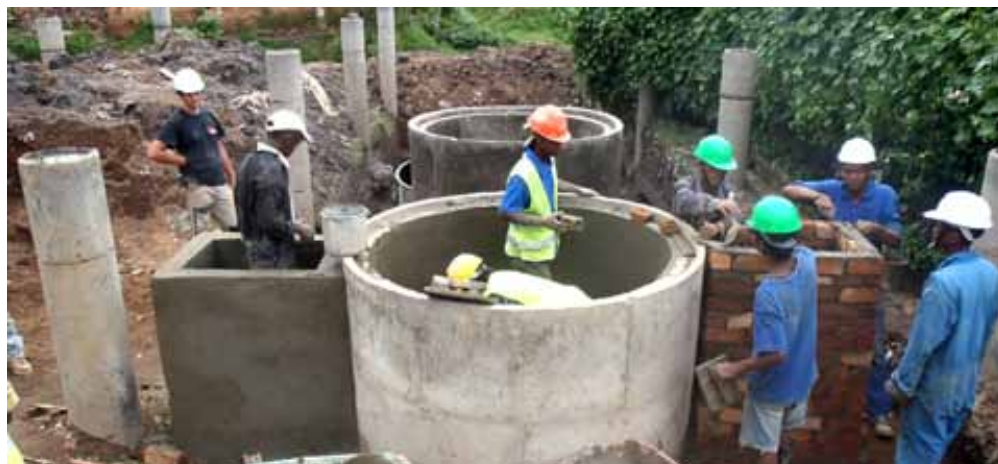
Construction d'une station de traitement des boues de vidange (Madagascar).
