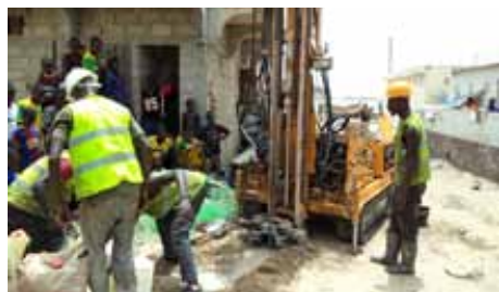
Réalisation de sondages pour les études géotechniques préalables à la construction d'un réseau d'égouts à Saint-Louis (Sénégal).
