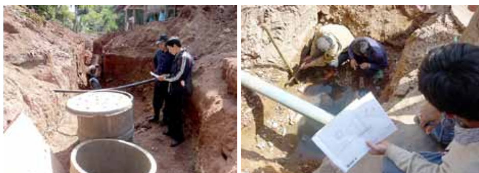
Construction d'un réseau d'égouts au Laos.
