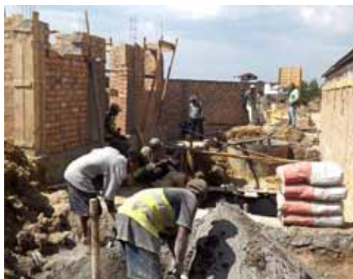
Chantier de construction d'une station de traitement à Antananarivo (Madagascar).
