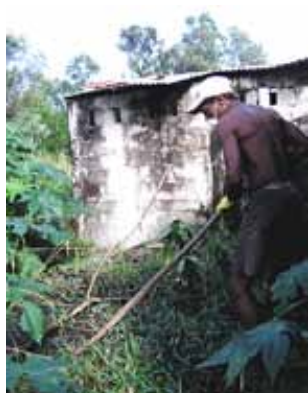
Ouverture de la fosse.
