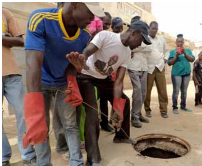
Entretien d'un réseau d'égouts conventionnel à Saint-Louis (Sénégal).
