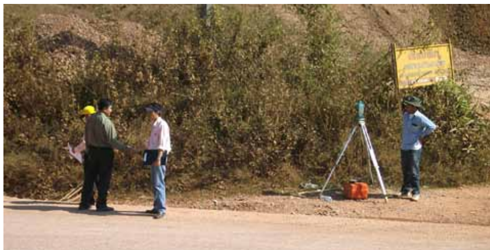
Étude topographique pour l'implantation d'un réseau d'égouts au Laos.
