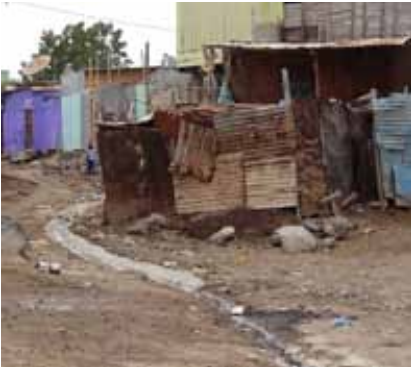
Écoulement d'eaux usées dans une rue de Djibouti (à gauche).
