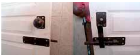
Loquets et poignées de porte des blocs sanitaires de Rosso (Mauritanie).
