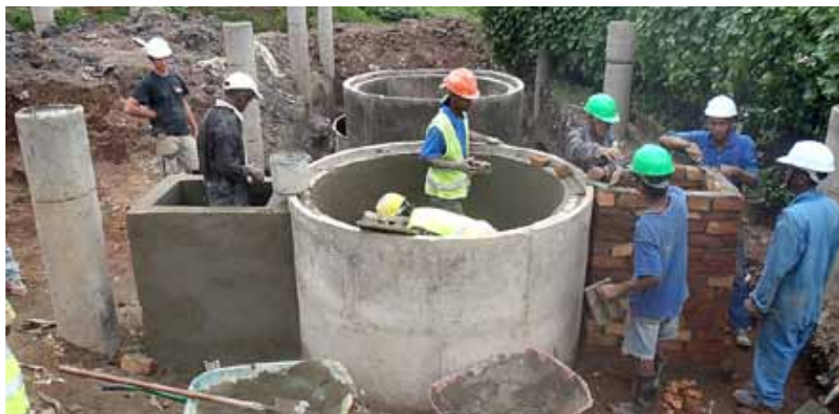
Construction de la station de traitement par biodigesteurs et filtre biologique à Tanjombato (Madagascar).
