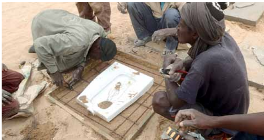
Construction d'une dalle de toilette au cours d'une formation de maçons en Mauritanie.
