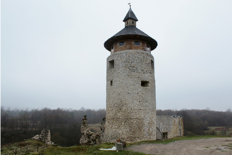
Abb. 79: Burg Drežnik Grad mit dem restaurierten Rundturm von Süden.
