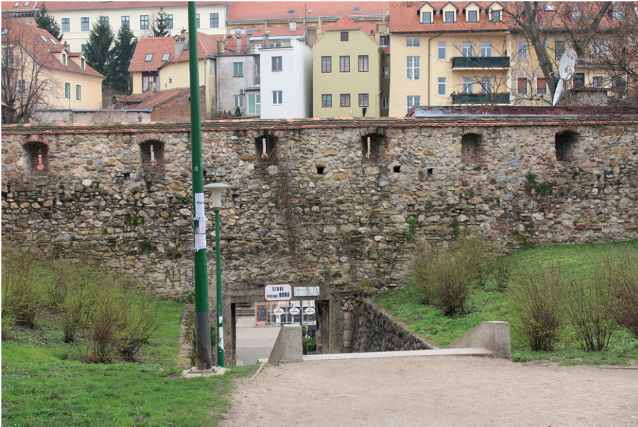
Abb. 96: Reste der westlichen Befestigung von Kaptol, des östlichen Teils der alten Doppelstadt Zagreb, am Abhang zum Straßenzug Tkalčićeva (ehemaliges Bachbett des Medveščak).
