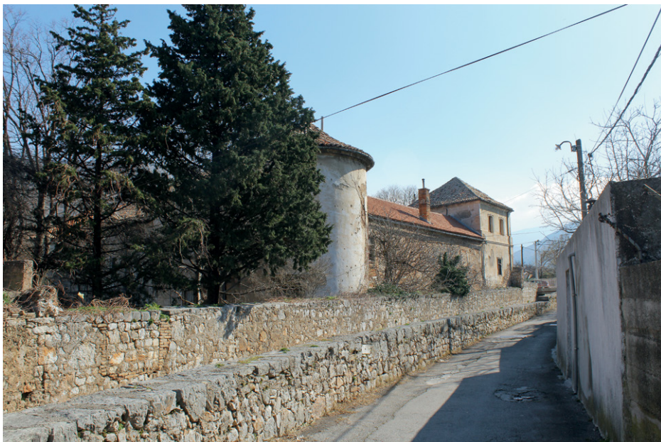
Abb. 87: Philipp-Turm und Eckturm des ehemaligen Kastells sowie Stadtmauer von Senj in der Ostecke der Stadtbefestigung am Bachlauf der Draga.
