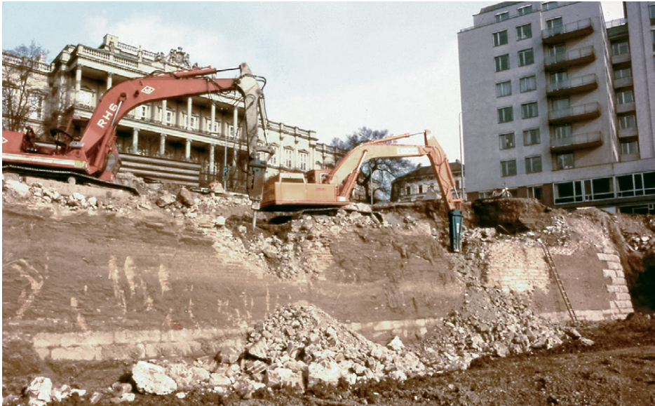
Abb. 59: Abbruch der Überreste der Unteren Paradeisbastei, 1983.
