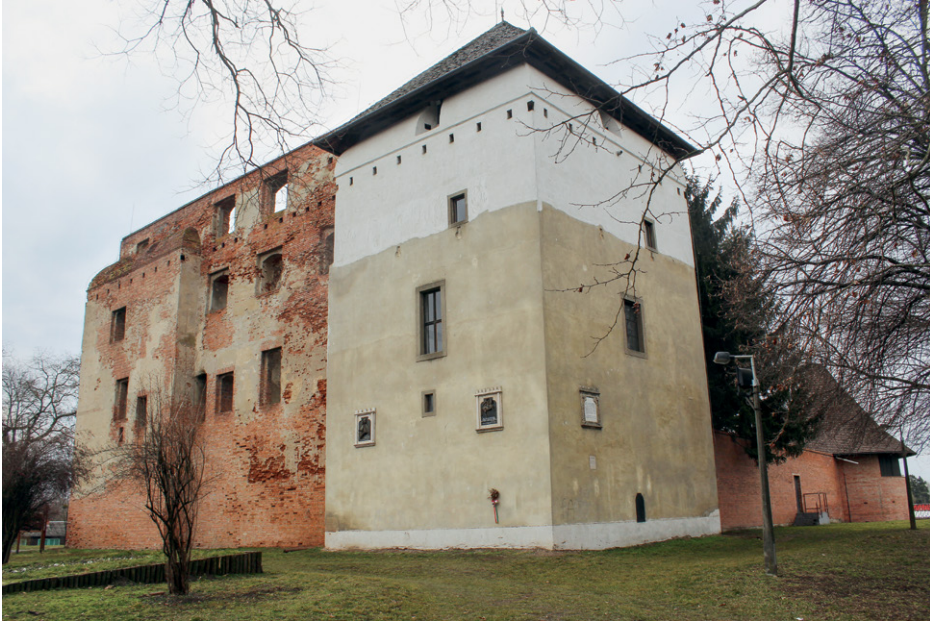
Abb. 81: Burg Kisvárda mit südöstlichem Eckturm von Süden.
