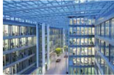
Abb. 7: Atrium des E.ON Standortes Brüsseler Platz in Essen.
