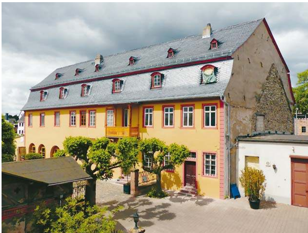
Abb. 7. Das Brentano-Haus nach der Außensanierung (Foto: privat).
