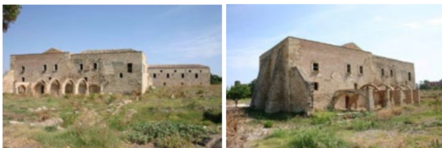
Fig. 8. Torre di Mare (Bernalda)
