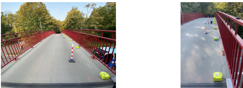
Abbildung 6.4: Sensorpositionierung entlang der Nordachse an der RWA-Brücke am 12.09.2020 (links) und Menhir-Geräte sowie deren externe GPS-Antennen auf dem Geländer (rechts)
