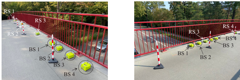
Abbildung 6.7: RWA-Brücke: Zwei Messaufbauten mit fünf Referenzsensoren ( RS ) und vier beweglichen Sensoren ( BS ) am 12.09.2020
