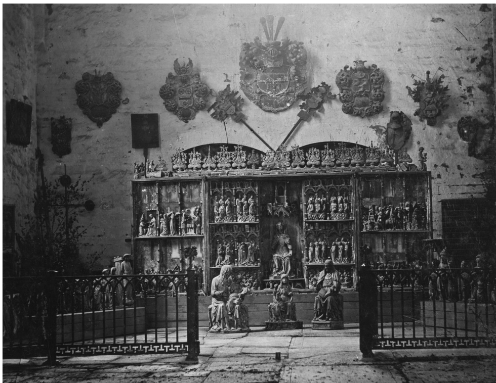
Bild 10. Uppställningen av skulpturer och begravningsvapen i klosterkyrkan före år 1890 års restaurering. Bilderna var då placerade framför den nordöstra porten. Foto ATA.
