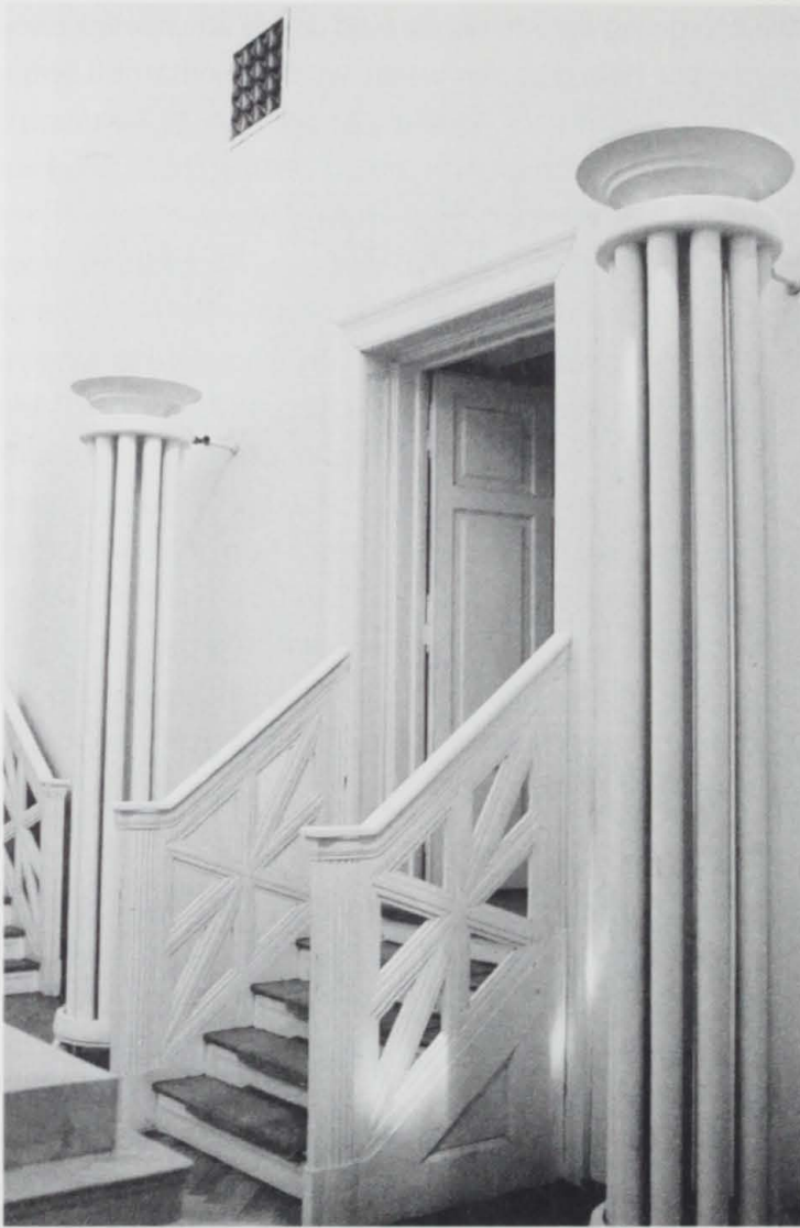
Abb. 54 Villa Toscana, Heizkörper (Prokop)
