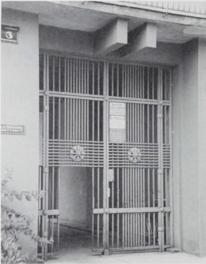
Abb. 106 Perco, Engelsplatz-Hof, Torgitter (Prokop)
