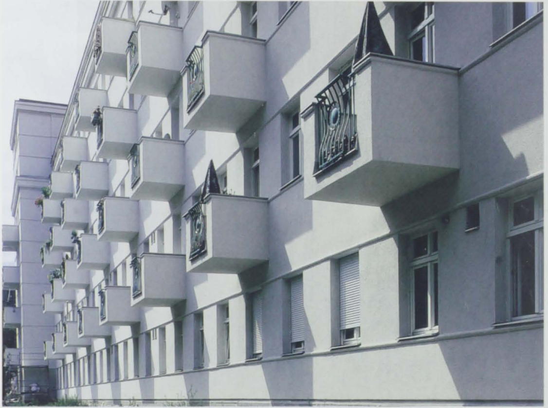
Engelsplatz-Hof, Fassadendetail (Ballon)
