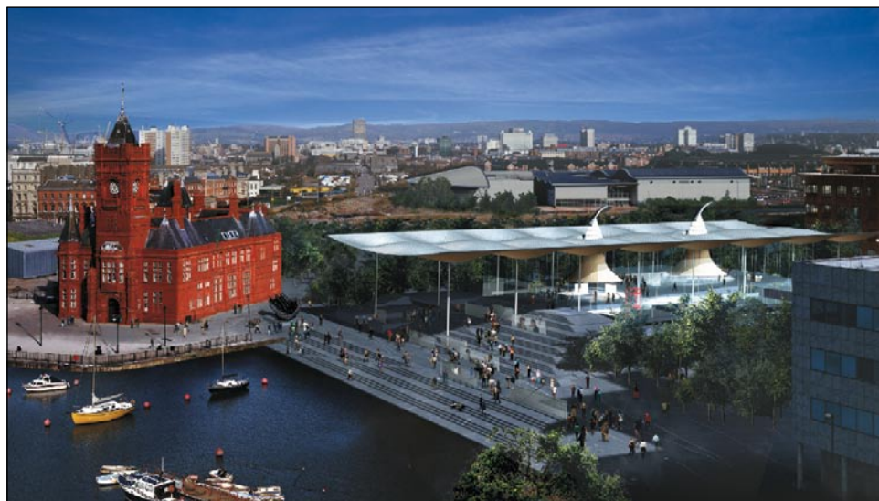
Fig. 17 Parlamento del Galles, Cardiff: immagine virtuale del nuovo edificio prospiciente la baia di Cardiff (RRP - Hayes davidson).
