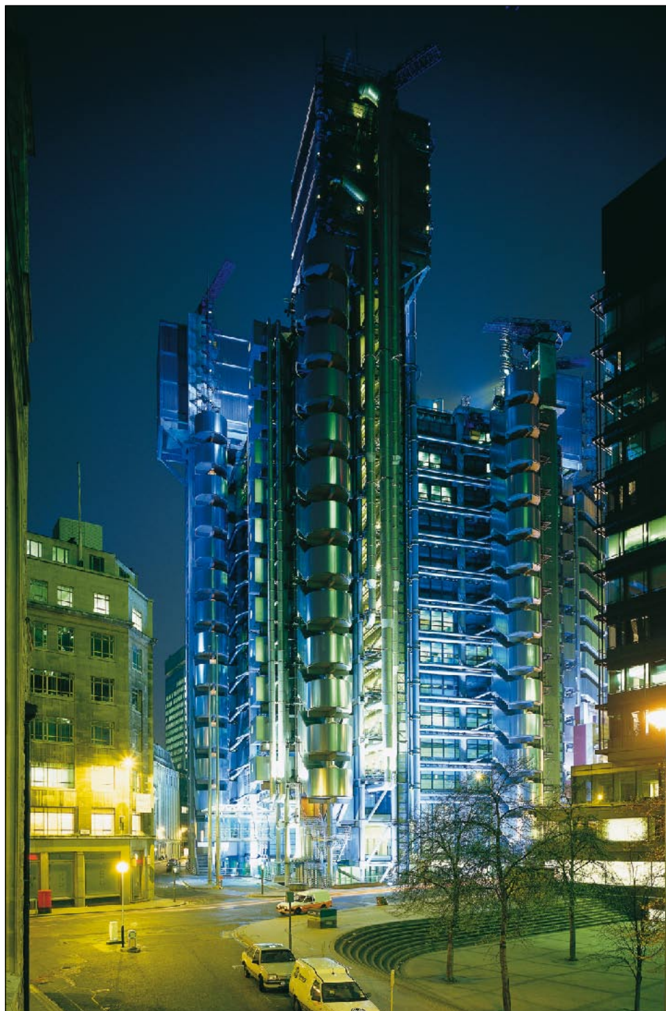
Fig. 9 Sede dei Lloyds a Londra: vista notturna dell'edificio da Commercial Union Plaza ( The Photographer - Richard Bryant/Arcaid).
