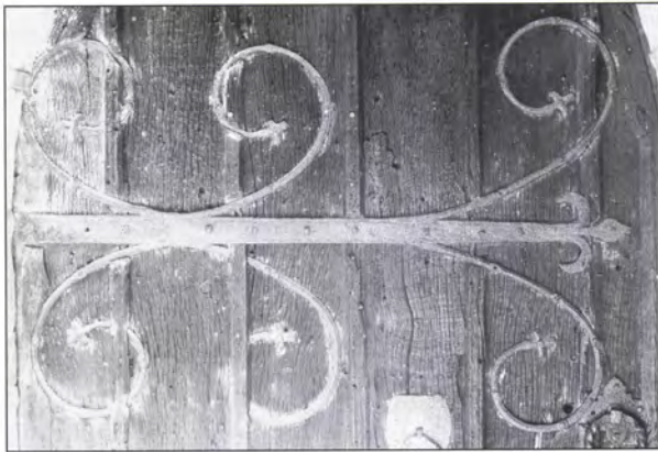
5.79 Caldecote (Warwickshire), detail.
