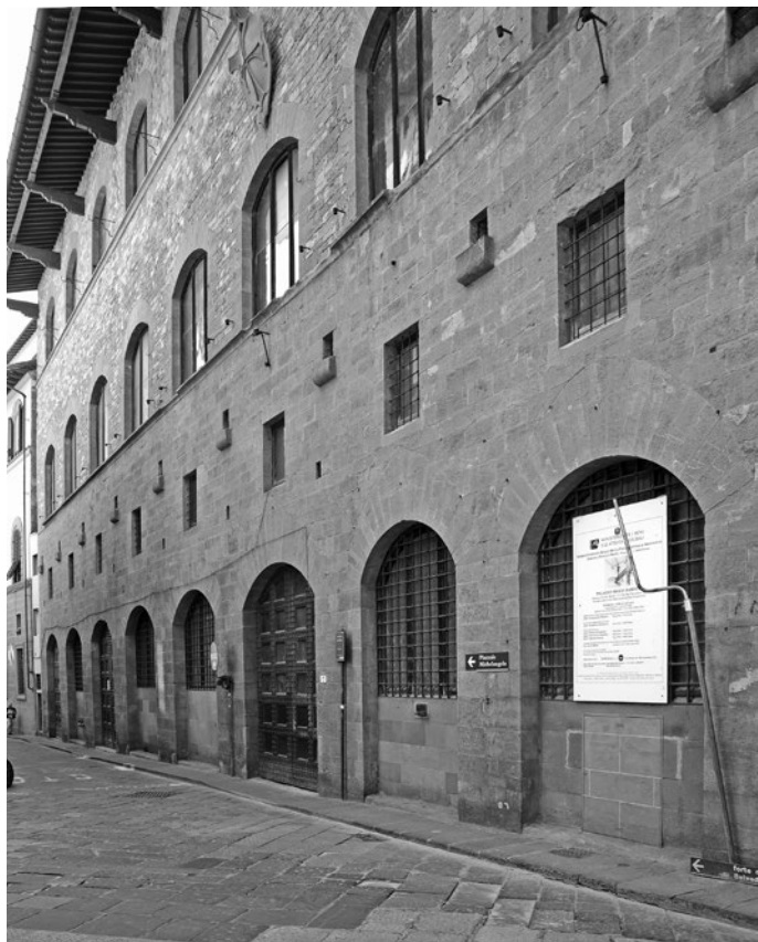
Fig. 32. Palazzo Mozzi, dettaglio del paramento; Firenze, via de' Bardi.
