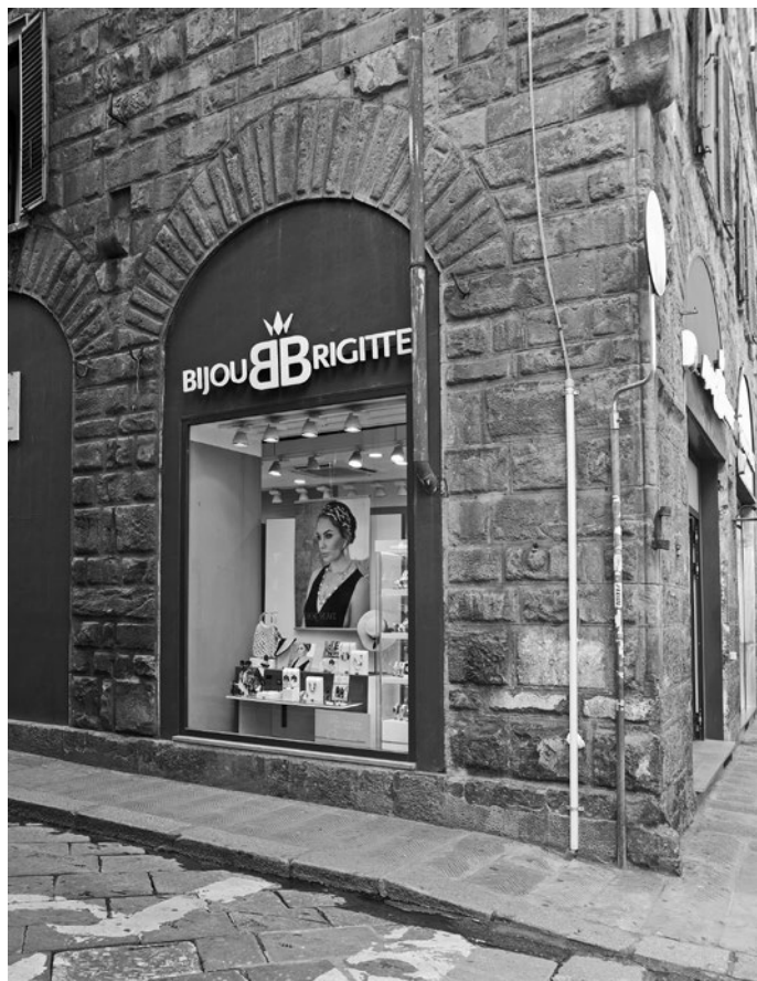
Fig. 71. Palazzo Bezzoli, dettaglio; Firenze, via de' Cerretani.
