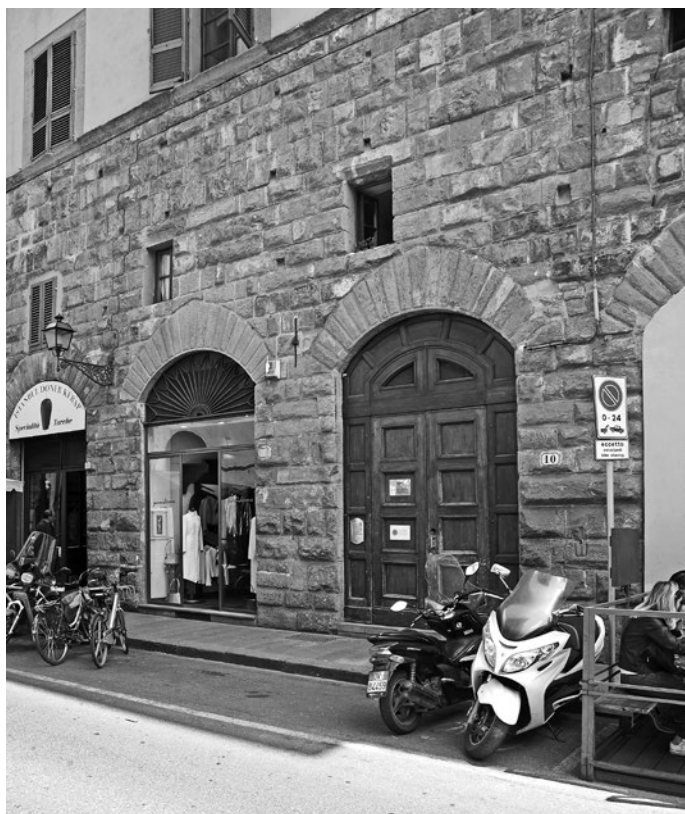
Fig. 78. Palazzo Alberti; Firenze, via de' Benci 10.
