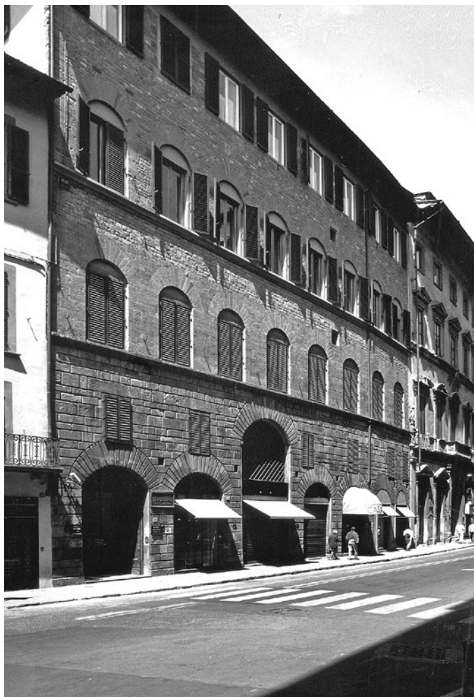
Fig. 73. Palazzo Minerbetti; Firenze, via de' Tornabuoni.
