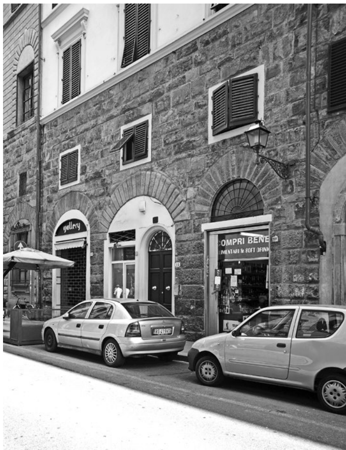
Fig. 80. Palazzo Alberti; Firenze, via de' Benci 14.
