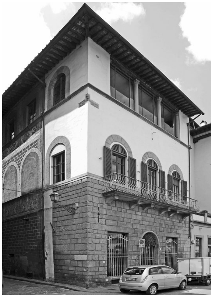
Fig. 91. Palazzo Capponi-Coverelli; Firenze, via Santo Spirito.
