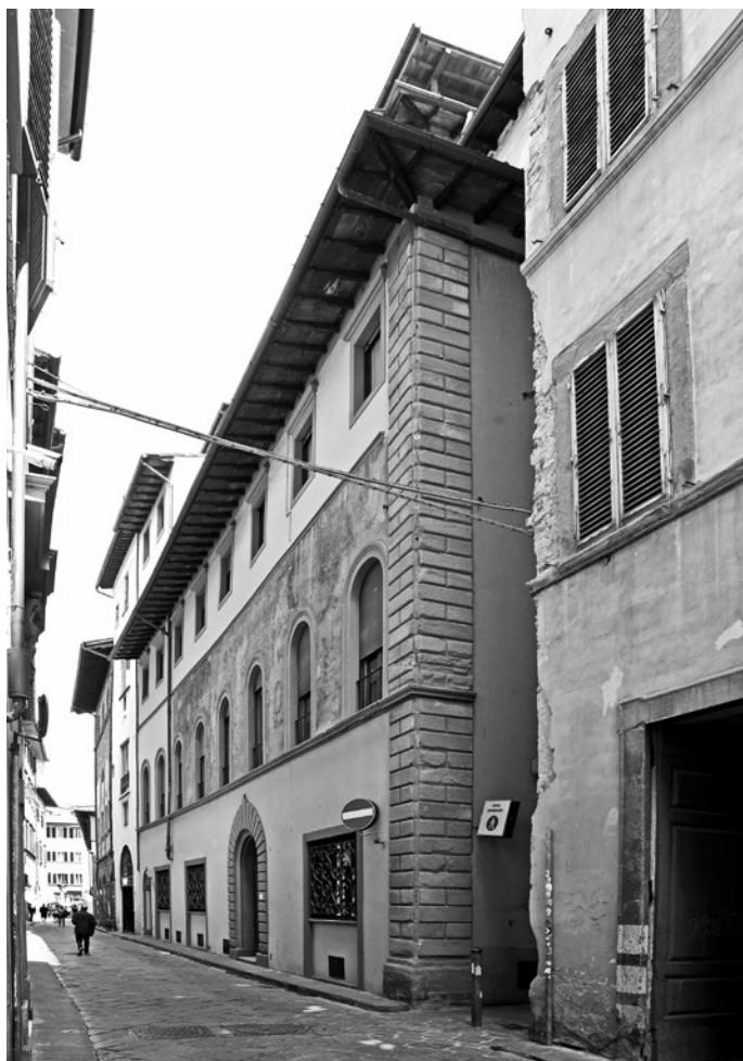
Fig. 124. Palazzo Mazzinghi; Firenze, via delle Belle Donne.
