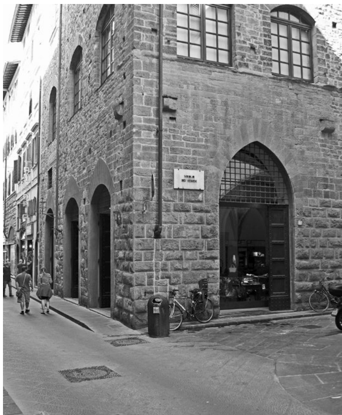
Fig. 56. Palazzo Cerchi; Firenze, via della Condotta.
