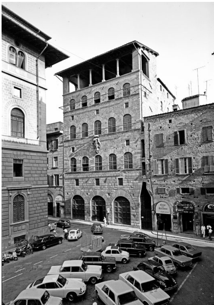
Fig. 19. Palazzo Spini; Firenze, via de' Tornabuoni.
