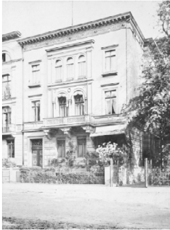
Das Wohnhaus der Brüder Grimm in der Lennéstraße 8 in Berlin, wo sie von 1841 bis 1846 wohnten. Photographie, um 1860 · Brüder Grimm-Museum Kassel: Photogr, Slg 1989 (G.J. Jungk)
