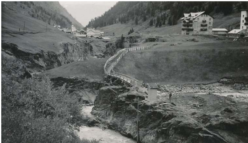
Abb. 3: Der Pegel Vent/Rofenache (vor 1936) auf dem Felssporn zwischen der Rofenache und der Spiegelache, auch Niedertalbach genannt. Pegelausstattung: Lattenpegel, Registrierpegel nach Schwimmerprinzip, behgbares Häuschen (Foto: Hydrographischer Dienst Tirol)
