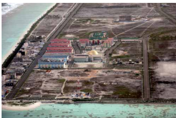
Figura 1.21. Il progetto ha avuto notevoli critiche dichiarandolo inutile alla risoluzione dei problemi dell'isola capitale, si prevede anzi il sorgere di nuovi problemi che coinvolgono non solo l'ambiente, ma anche l'organizzazione sociale sul territorio delle isole. La domanda ricorrente è: perché realizzare una nuova isola quando fra le duemila isole dell'arcipelago delle Maldive novecento sono disabitate? Una analisi demografica di Malé dimostra che la l'80% della popolazione è composta da studenti e che pertanto una giusta pianificazione che preveda il decentramento dei plessi scolastici sulle altre isole possa risolvere il problema del sovraffollamento in maniera significativa. La cospicua somma di denaro utilizzata finora avrebbe risolto parecchi problemi anche di natura urbana
