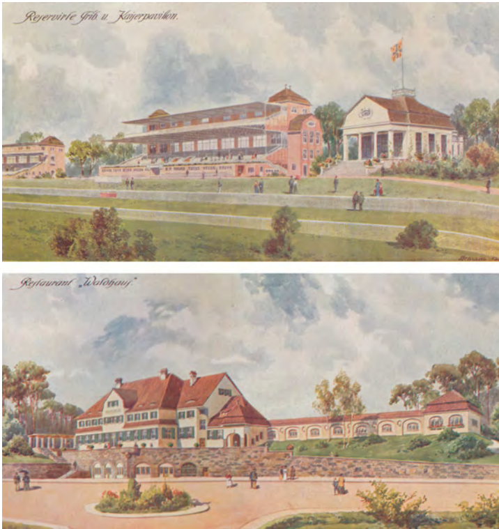
Abb. 72 Otto March, Rennbahn Grunewald. Tribünenbauten u. Kaiserpavillon (oben); Restaurant ›Waldhaus‹ (unten)
