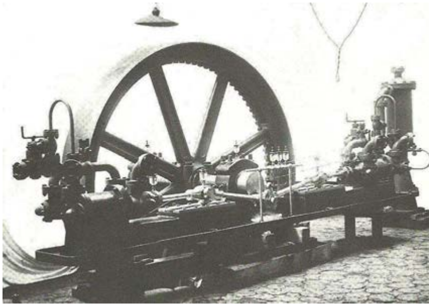
Compressore ad ammoniac per impianti frigoriferi delle Fonderie del Pignone (1911) [M. Pacini, La Fonderia del Pignone e gli ingegneri nella Firenze dell'Ottocento in F. Angotti, G. Pelosi, S. Soldani (a cura di), Alle radici della moderna ingegneria – Competenze e opportunità nella Firenze dell'Ottocento , Firenze University Press, Firenze, 2010, pp. 87-106].
